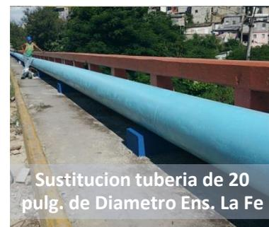
Sustitución tubería de 20 pulg. de Diámetro Ens. La Fe
