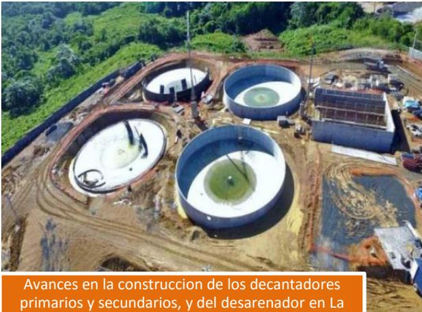
Avances en la construcción de los decantadores primarios y secundarios, y del desarenador en La Estación Depuradora de aguas residuales La Zurza
