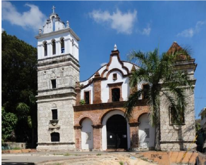
RESTAURACIÓN DE LA ESTRUCTURA DEL MONUMENTO HISTÓRICO IGLESIA SANTA BÁRBARA, ZONA COLONIAL, D.N.
