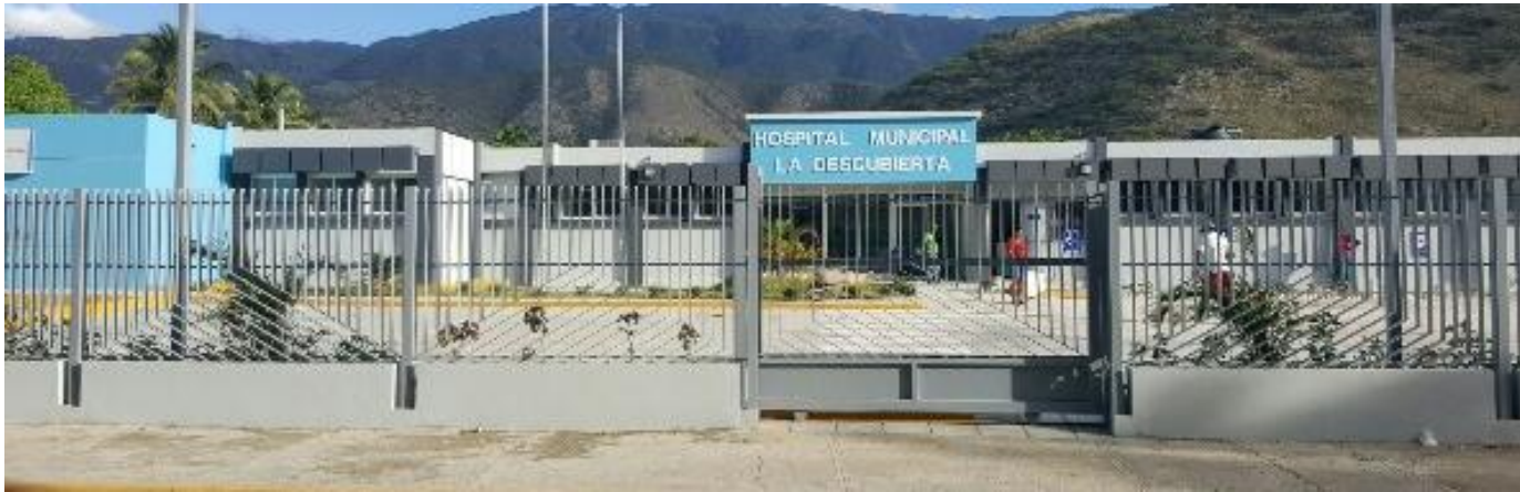
HOSPITAL MUNICIPAL LA DESCUBIERTA
