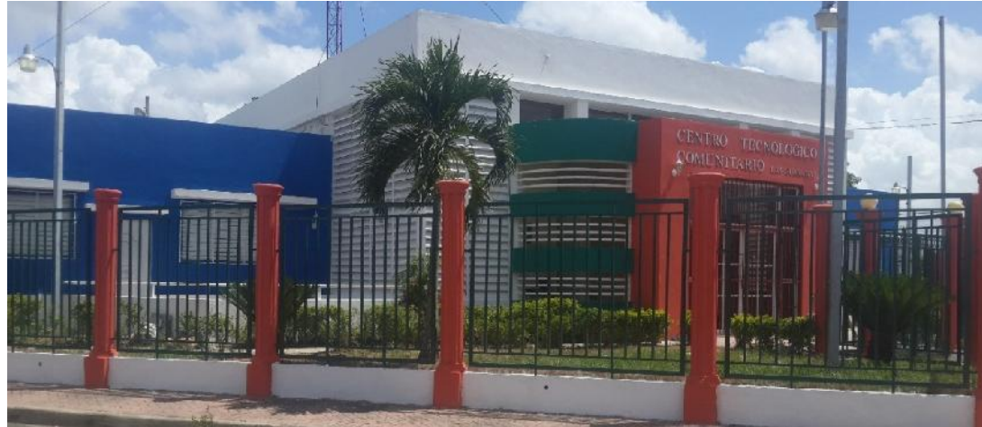
CONSTRUCCIÓN DEL EDIFICIO CENTRO TECNOLÓGICO COMUNITARIO (CTC) LAS GUÁRANAS, PROVINCIA DUARTE
