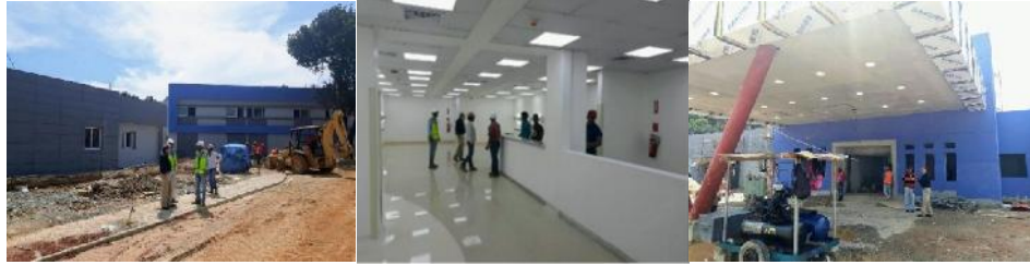
Supervisión de la ejecución de trabajos en Hospital Moscoso Puello.
