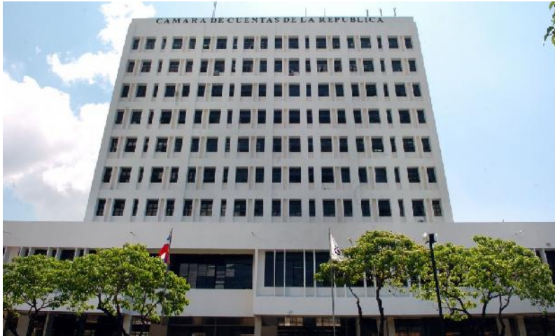
TERMINACIÓN DE LA CÁMARA DE CUENTAS DE LA REP. DOM.
