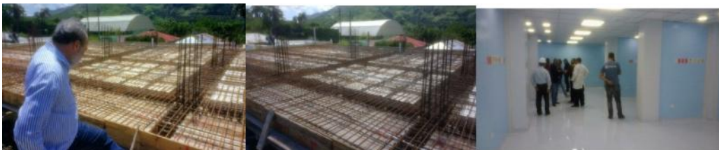
Supervisión construcción del Hospital de Hondo Valle, de la provincia Elías Piña.
