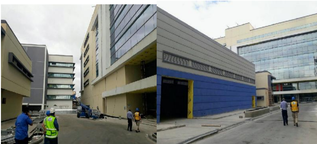
Supervisión avance general de trabajos en la moderna Ciudad Sanitaria.
