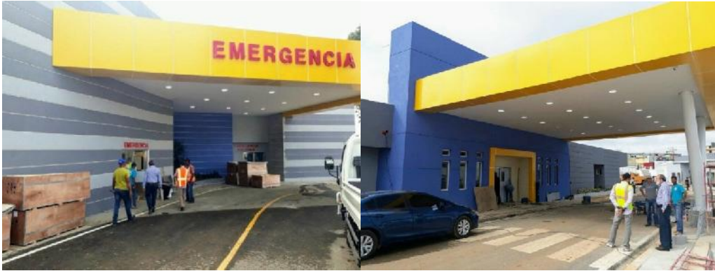
Supervisión trabajos finales reconstrucción hospital Moscoso Puello.
