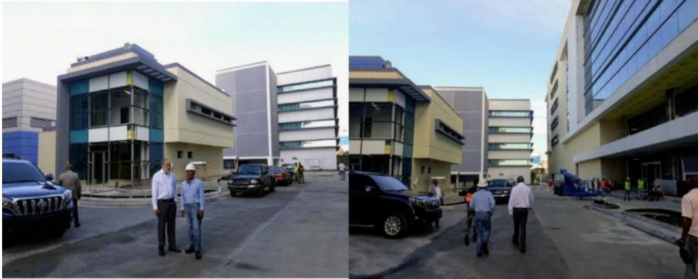
Supervisión ejecución proyecto Ciudad Sanitaria, de acuerdo al programa de terminación
