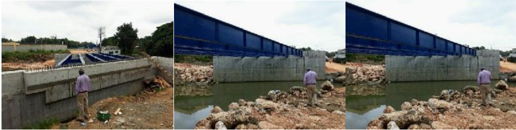
Supervisión trabajos construcción puente sobre río Arroyo Lebrón, de Los Alcarizos.
