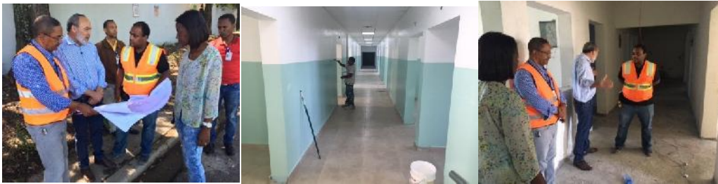
Supervisión avance de reconstrucción Hospital Rosa Duarte, Elías Piña.
