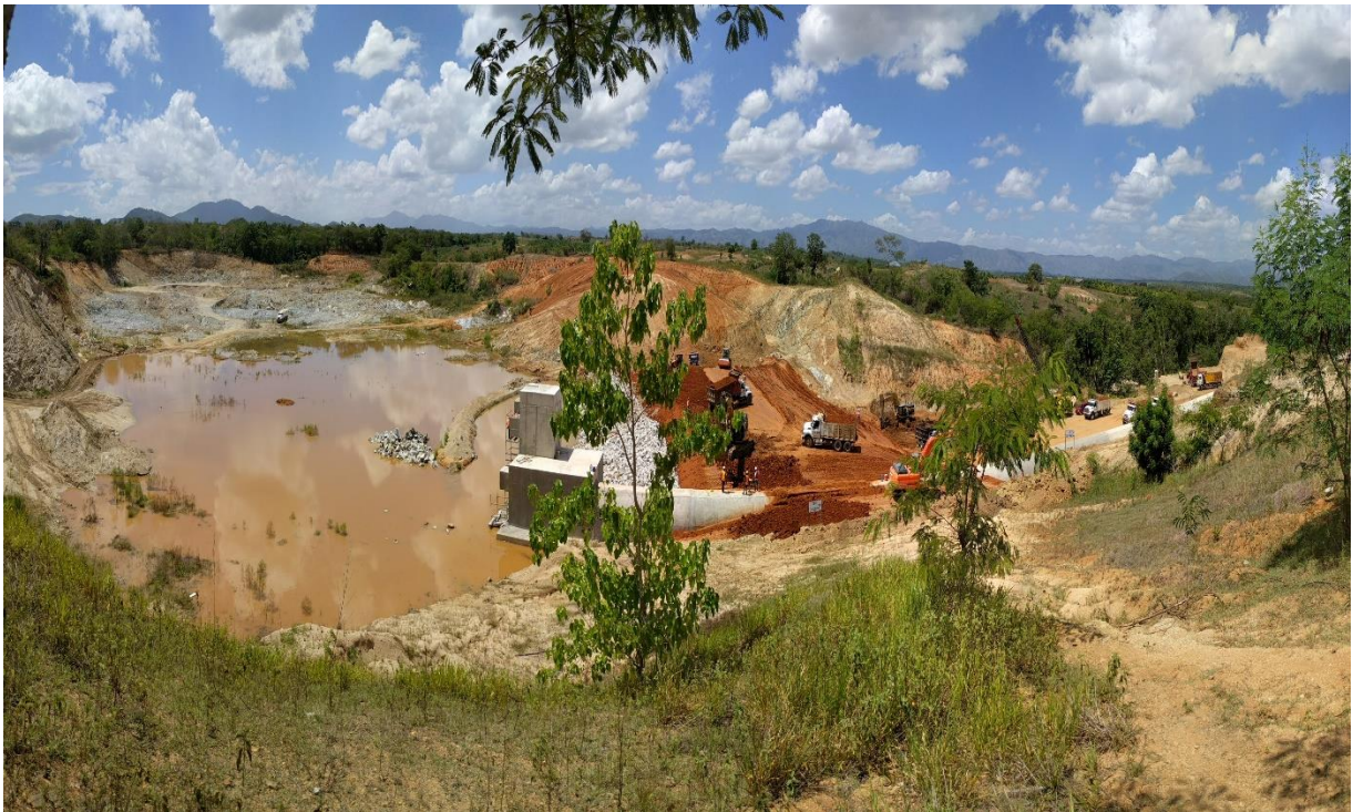
Presa La Piña Vista panorámica, de los caminos de accesos, ataguía y obra de toma.
