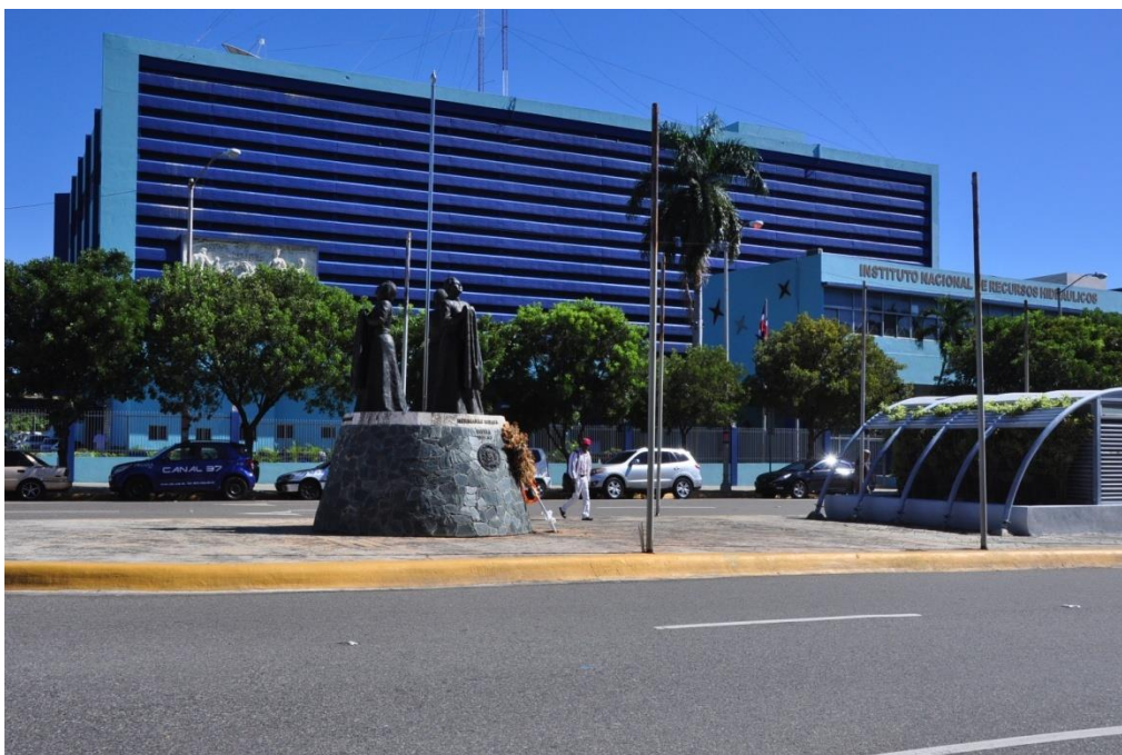
Remodelación edificio I INDRHI
