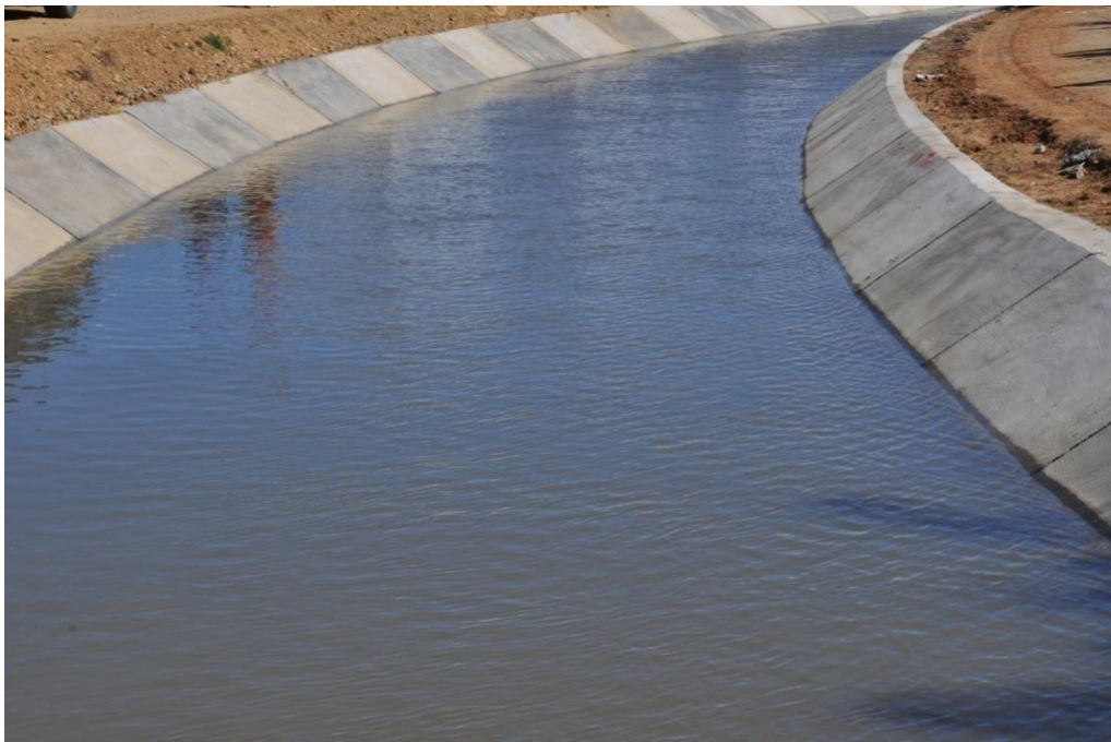
Canal Fernando Valerio, Las Matas de Santa Cruz, Montecristi
