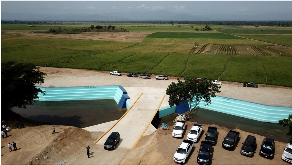
Puente badén, Sanché, Dajabón
