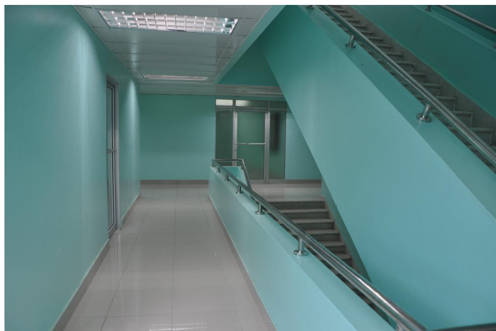
Remodelación edificio I INDRHI
