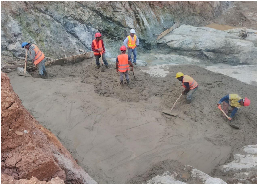
Completivos trabajos del plinto en pie de talud estribo izquierdo del Dentellón
