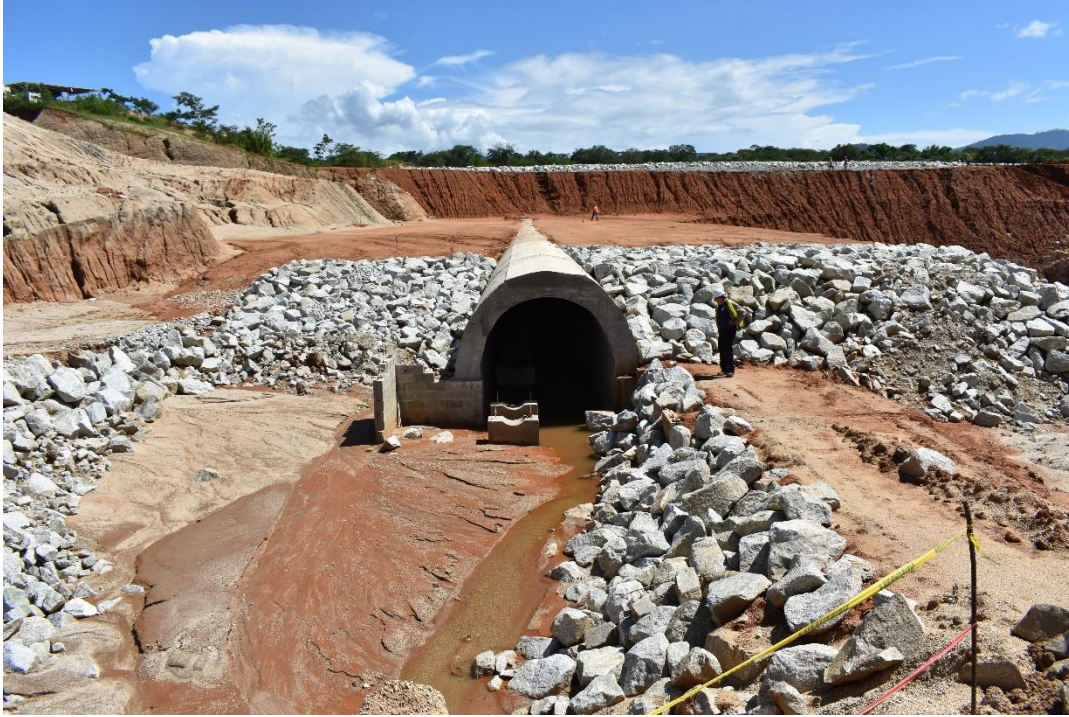
Presa La Piña Obra de salida del túnel de Desvío
