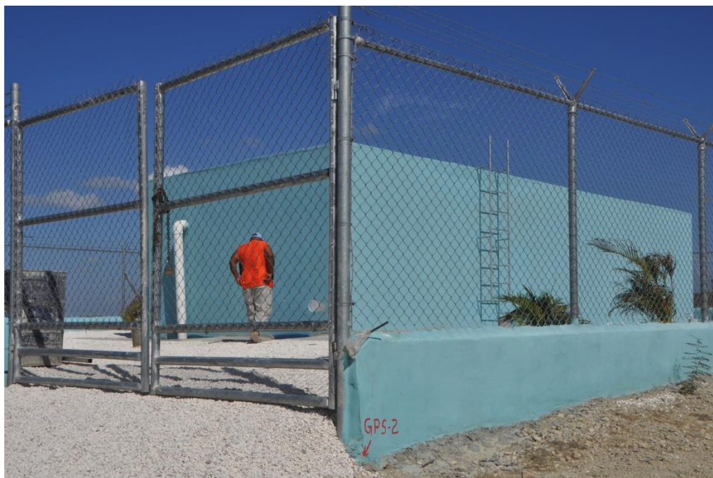
Construcción de acueducto Las Yayitas, Azua
