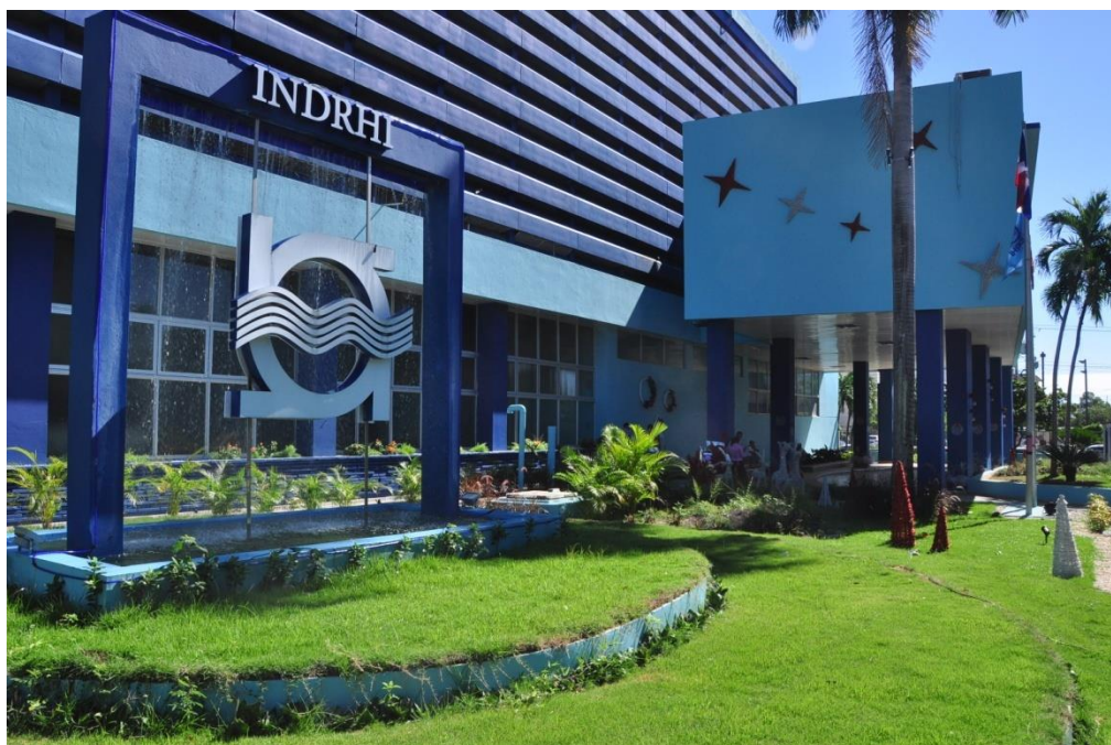
Remodelación edificio I INDRHI
