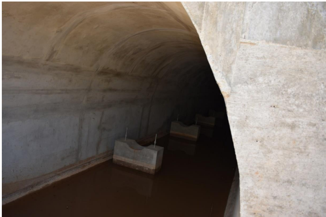
Presa La Piña Desvío agua del embalse atreves del túnel
