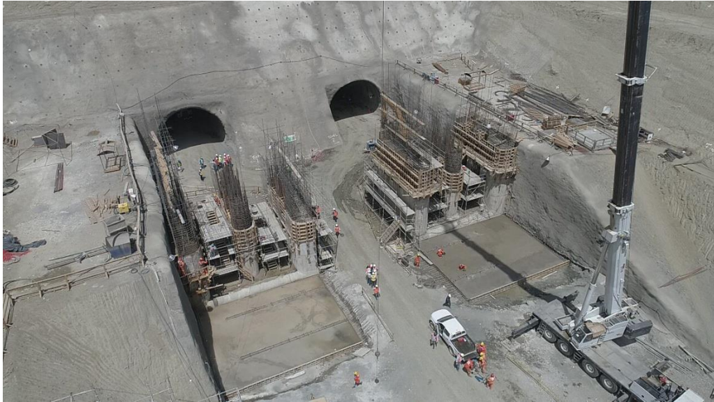
Túnel de llamada de la Presa Monte Grande, Barahona
