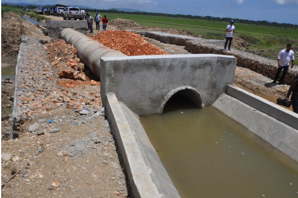
Canal G-2 alcantarilla y baden, Sabaneta, Nagua
