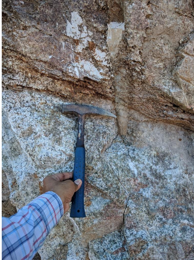
Presa La Piña Roca en Proceso de rotura
