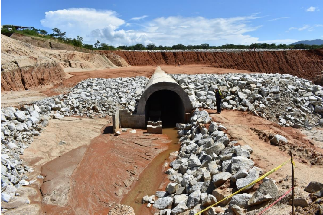
Presa La Piña Canalización obra de salida provisional
