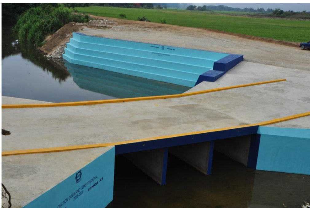
Puente baden, Sanché, Dajabón
