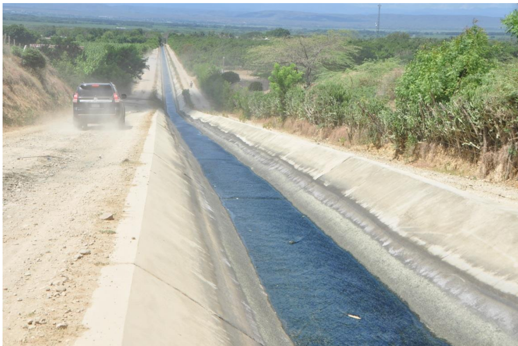
Rehabilitación de Bermas Canal Mao Gurabo
