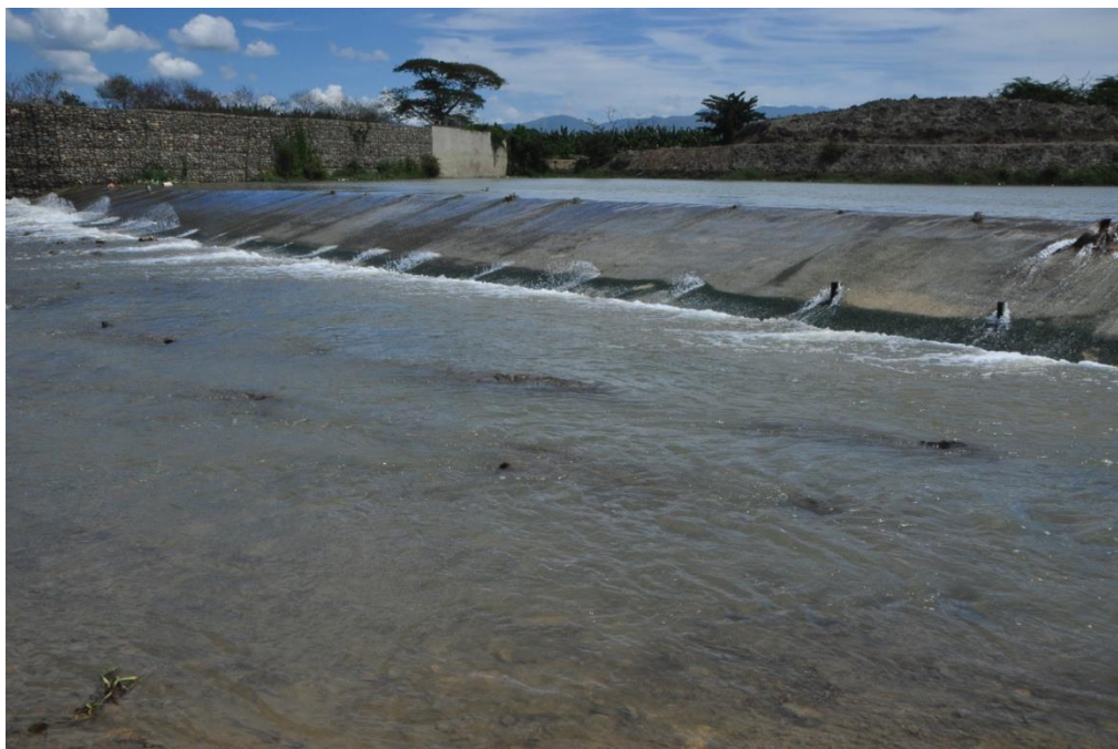
Canal-dique Cañeo, Esperanza, Valverde
