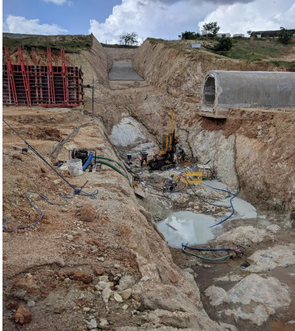
Presa La Piña Trabajos de perforación para inyección en el dentellón, debajo del tramo no.6, túnel de desvío.
