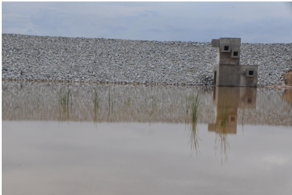
Obra de toma Presa La Piña, Dajabón
