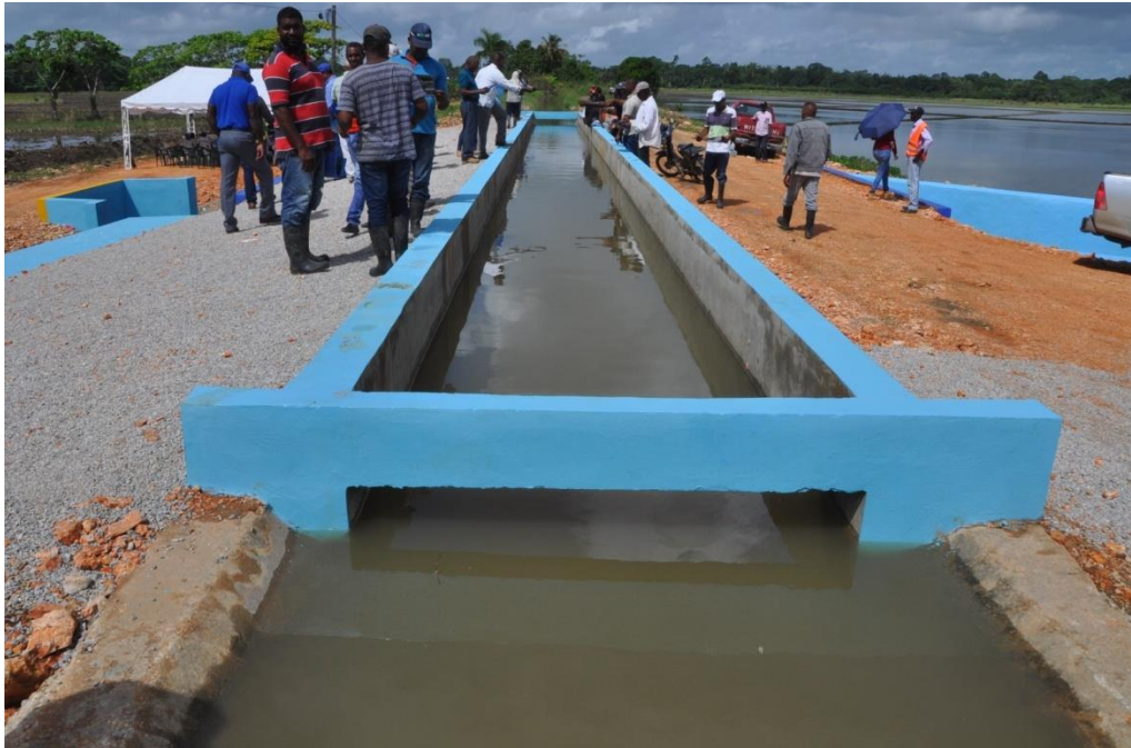
Rehabilitación Canal CR.A-1.5 Molenillo, Nagua
