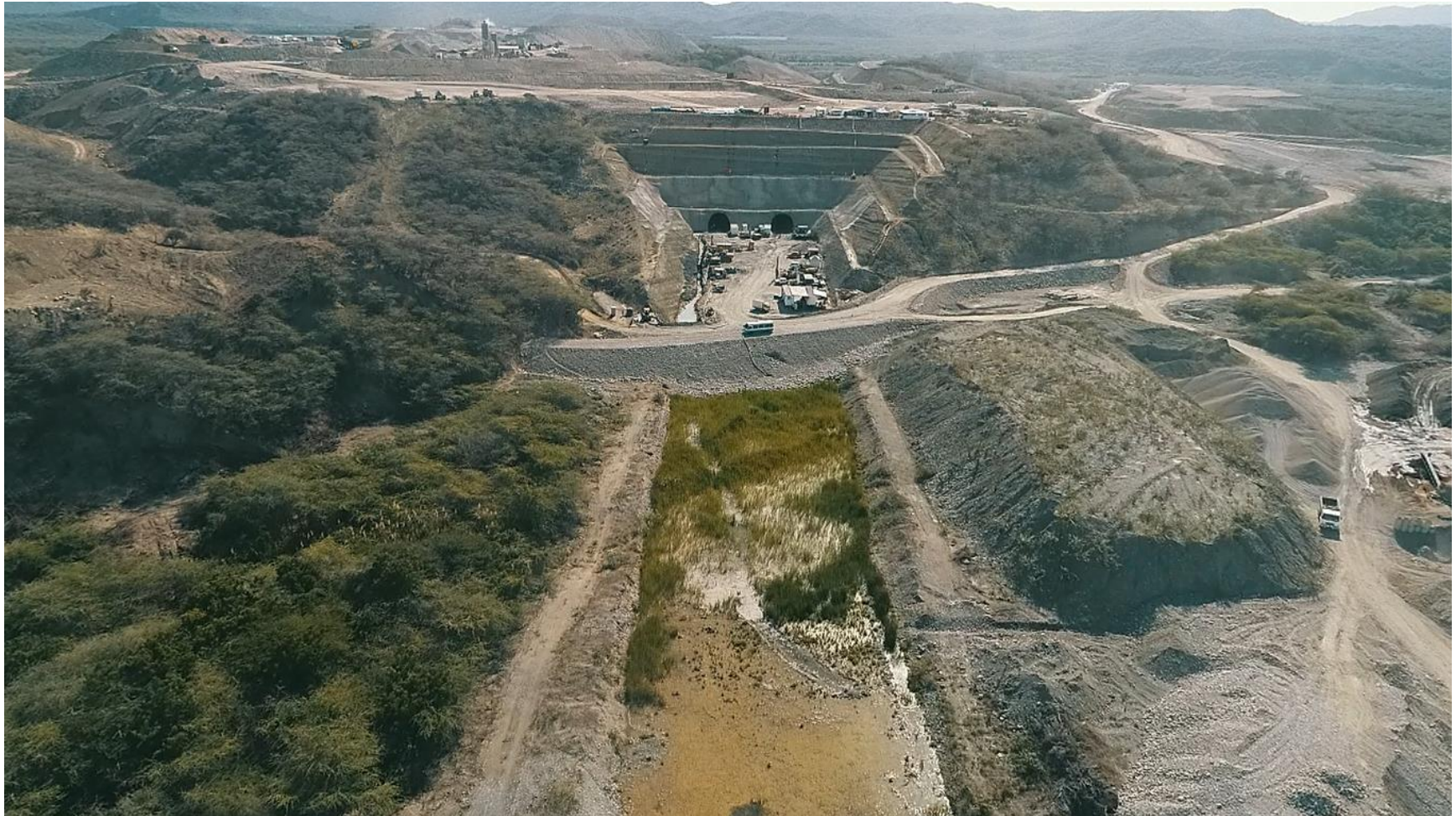
Presa Montegrande. Movimiento de tierra
