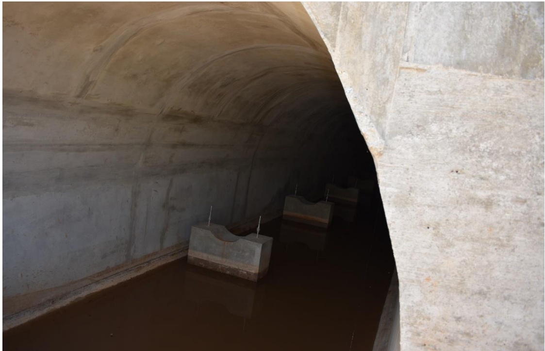
Presa La Piña Dados de apoyo en túnel de desvío, para colocación de tubería
