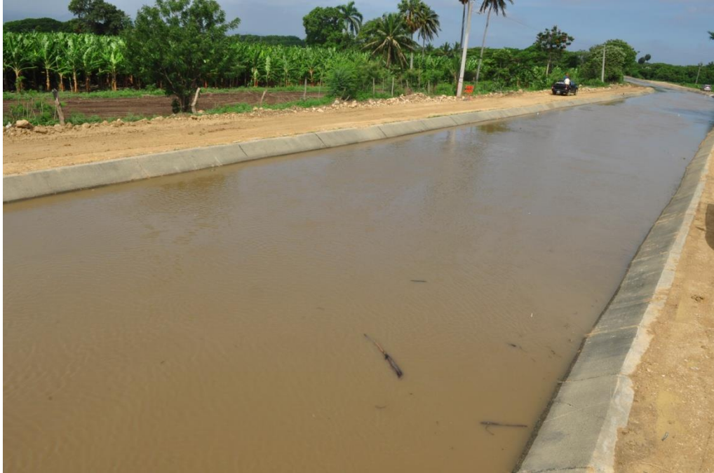
Canal principal Ulises Fco. Espaillat, Villa González , Santiago
