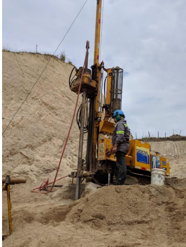
Presa La Piña Equipos utilizados para perforaciones e inyecciones
