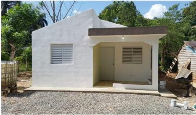
Construcción de vivienda a favor de la Asim. Militar Juliana R. Alberto De Lora, ERD.
