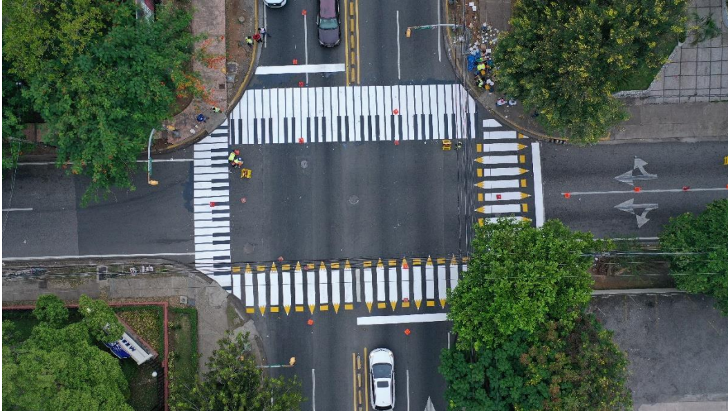
Imagen 12. Implementación de Urbanismo Táctico en cruces peatonales estación L1 Casandra Damirón.
