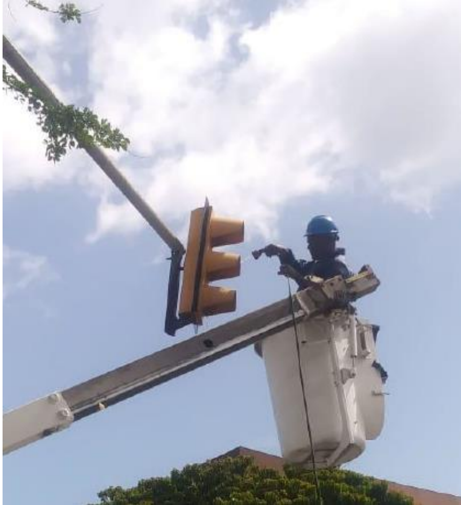
Imagen 13. Mantenimiento Preventivo en cuerpo semafórico.
