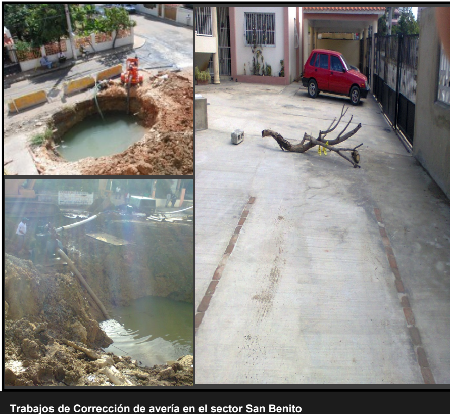
Trabajos de Corrección de avería en el sector San Benito
