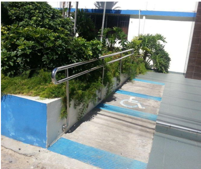
Rampa Frontal de acceso a la Institución
