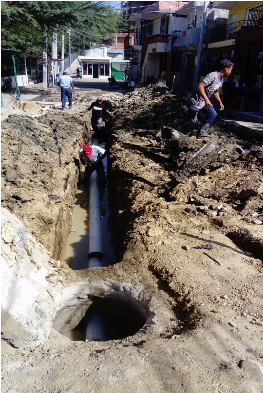
Sustitución de 25 mts. de tubería de 8" PVC en C/ 17 Prolongación 17 de Abril, El Ejido
