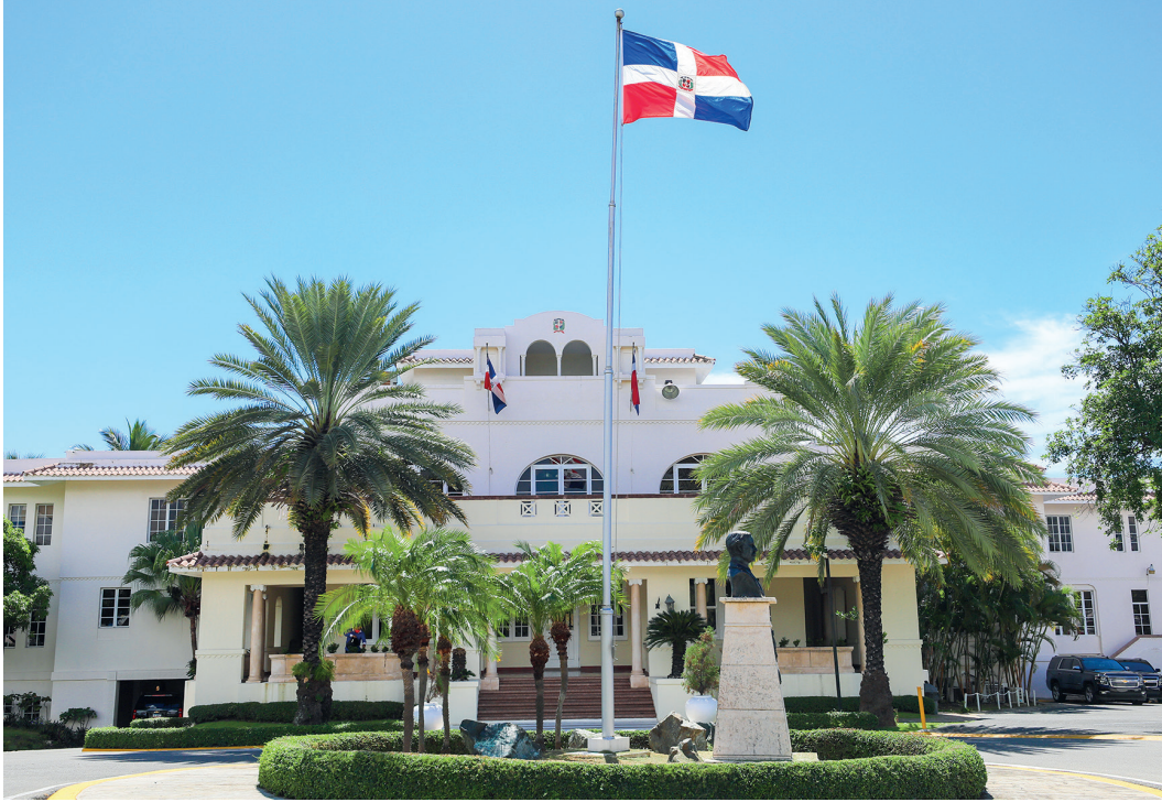
Fachada de la Cancillería, sede del Ministerio de Relaciones Exteriores.
