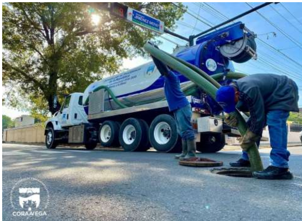
Camión Succionador en operativo de limpieza de alcantarillado.
