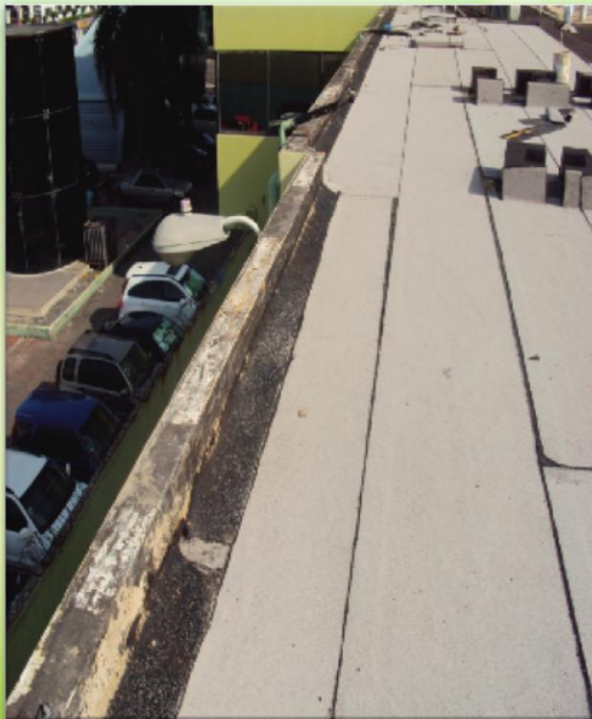
Trabajos de terminación de la aplicación de impermeabilizante en la nueva losa del 2do nivel. Edificio principal.
