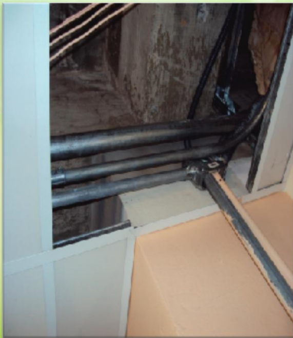
Trabajos eléctricos, cambio de cables y cajas de breakers, de luminarias y tuberías EMT.
