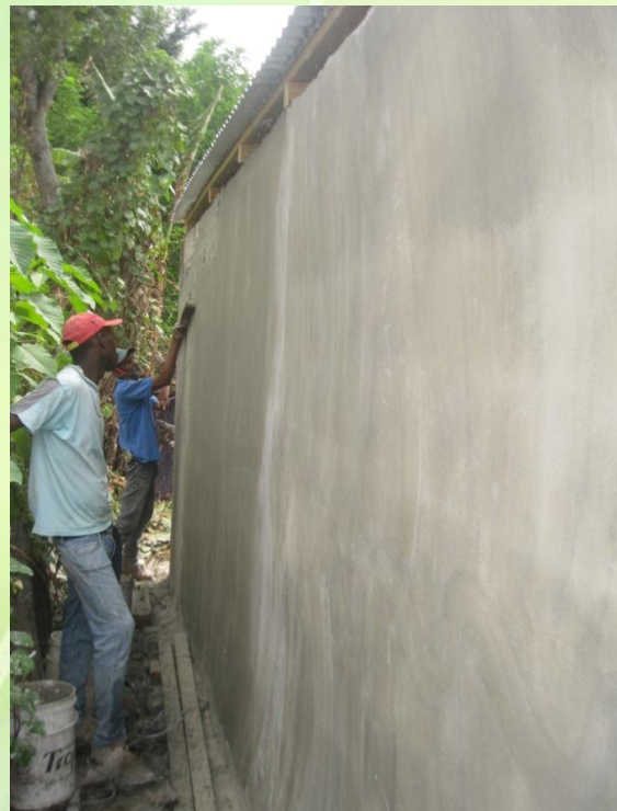
Trabajos de reconstrucción de techo en madera, zinc y empañete en muros
