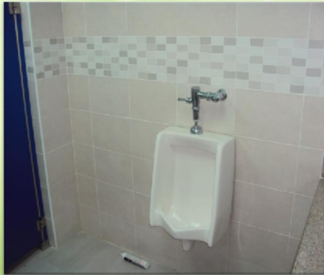
Detalles de la terminación de la reconstrucción baño para hombres, del 3er nivel.
