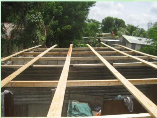
Trabajos de reconstrucción de techo en madera, zinc y empañete en muros
