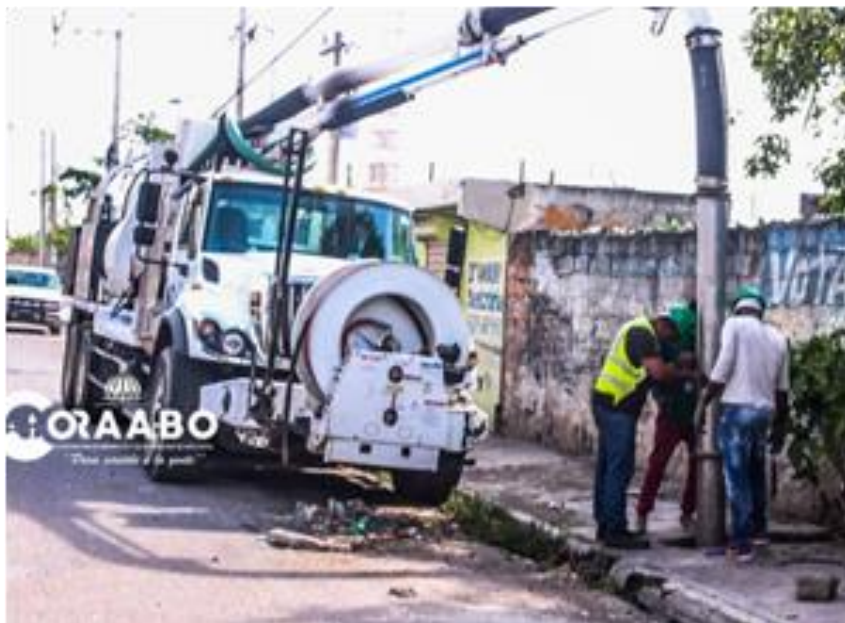
Figura 1. Trabajos realizados con el camión Hidrosuccionador
