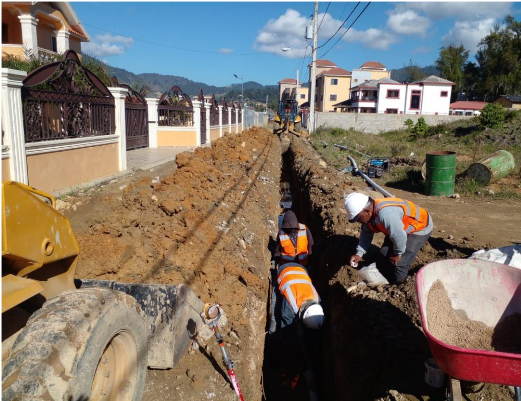
Construcción Acueducto de Tiro, Contanza, 2022.
