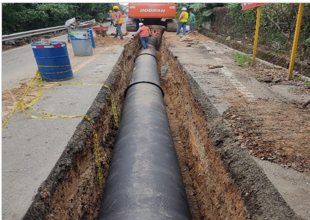
Construcción Línea de Aducción, Ac. De Jarabacoa.
