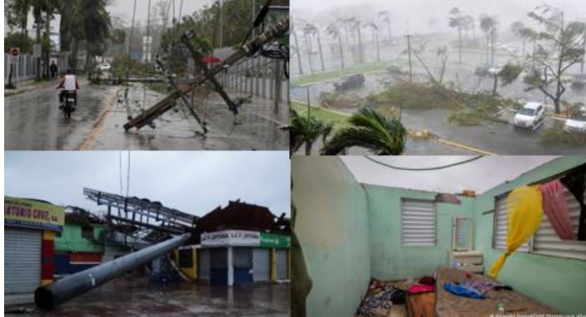
Imágenes: 25,26, 27 y 28: Daños provocados por Fiona tras el paso por la República Dominicana en el mes de septiembre.
