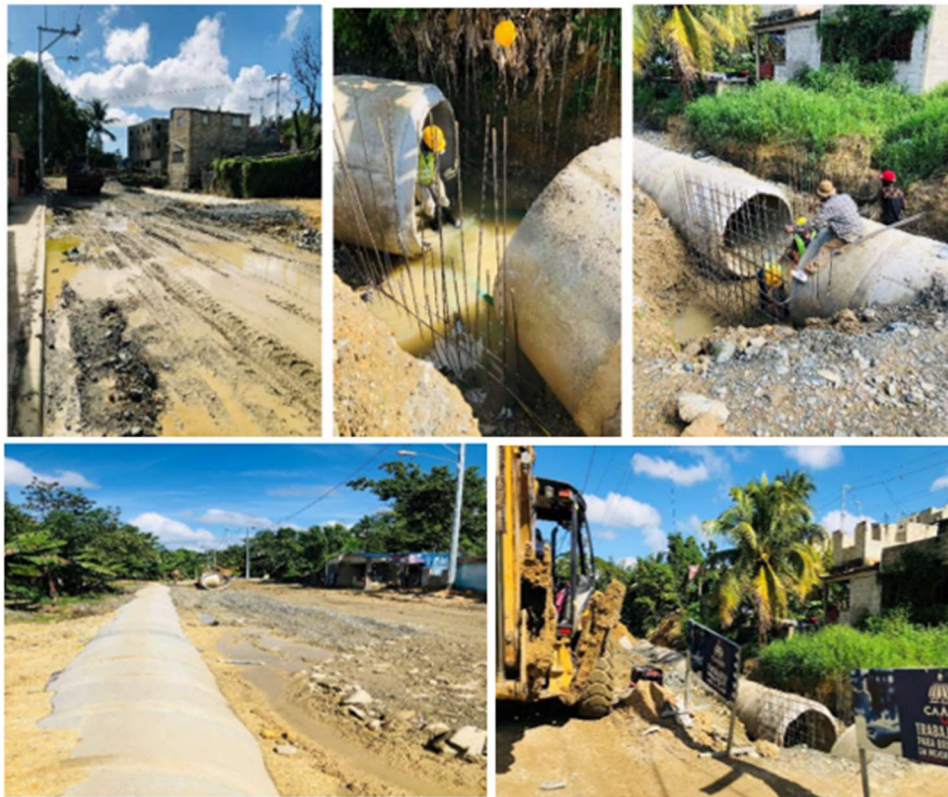
Trabajos de saneamiento cañada Villa Emilia
