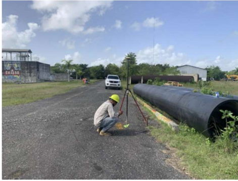
Trabajos de nivelación y replanteo topográfico
