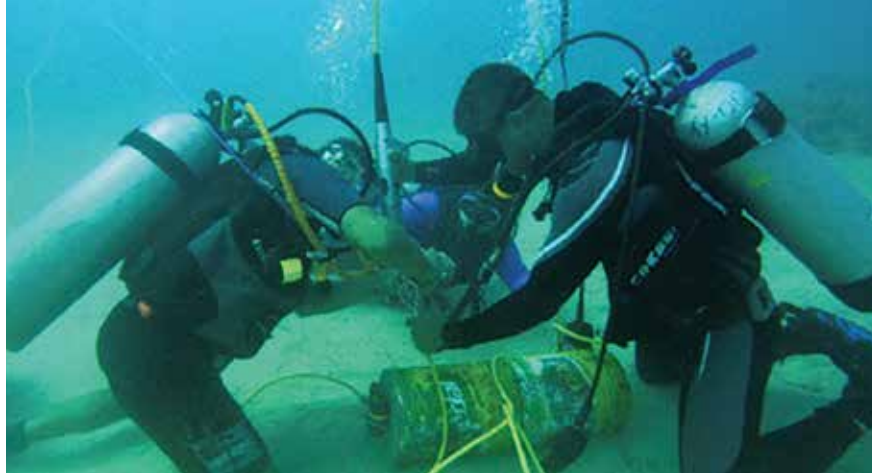
Imagen 2: Equipo de buceo técnico durante la instalación de la boya oceanográfica Spotter.
