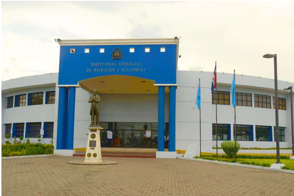
Fachada Frontal Dirección General de Pasaportes
