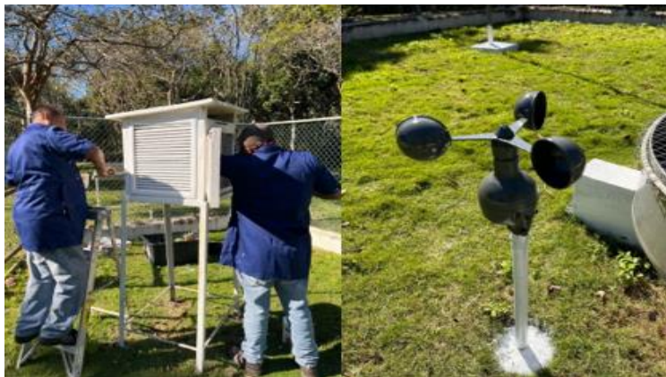
Imagen 23: Mantenimiento realizado a la estación jardín botánico.
