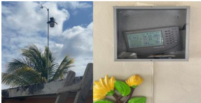
Imagen 35: Estaciones instaladas en pedernales y san juan de la Maguana.
