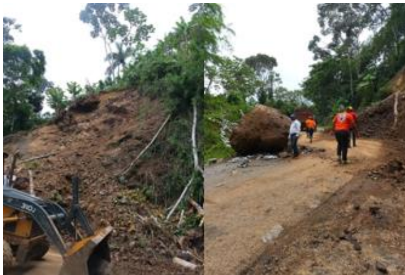
Imagen 14, 15 y 16: muestran deslizamiento de tierra y rocas, en la provincia Monseñor Nouel (Bonaó) el día de mayo.
