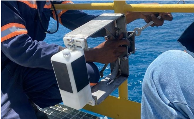
Imagen 1. Mareógrafo siendo instalado en el puerto de Punta Catalina, Peravia.
