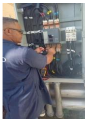
Rehabilitación de Luminarias externas del Palacio Nacional
