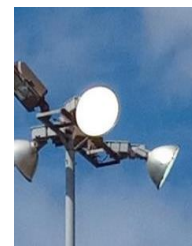
Correcciones eléctricas en instalaciones de fuerza, Casa Santiago.
