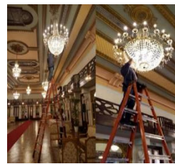
Cambio de luminarias salón Las Cariátides.
