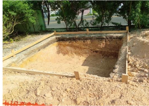
Excavación de nuevo Pórtico
