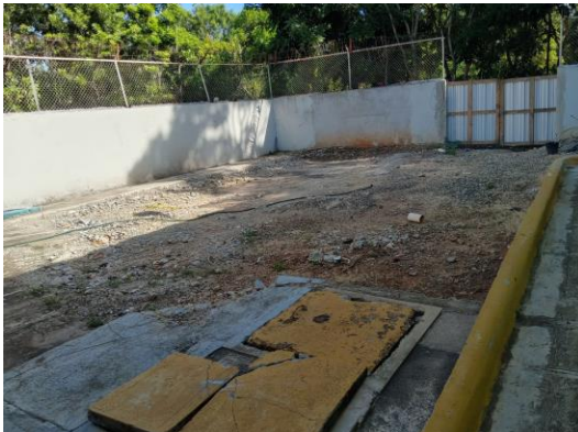
Demolición de Caseta
