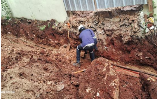
Extracción de Cables
