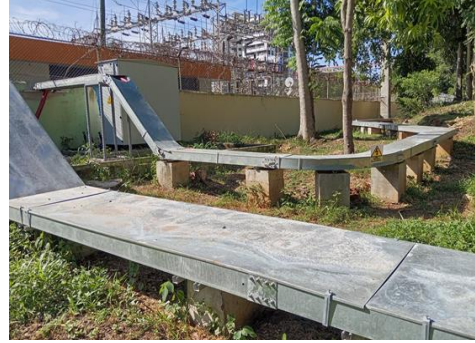
Reubicación provisional de cables
