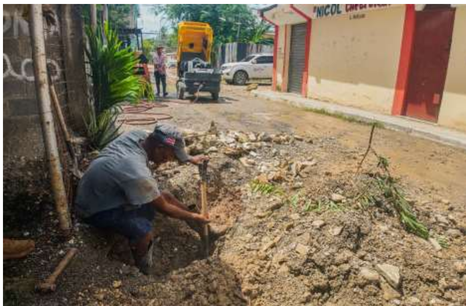
Trabajos de Cateo y desobstrucción de líneas
