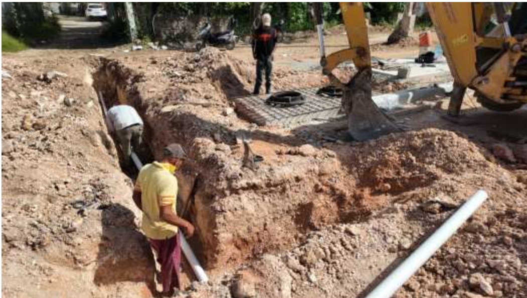
Reparación de Averías y Construcción de Registro Operacional
