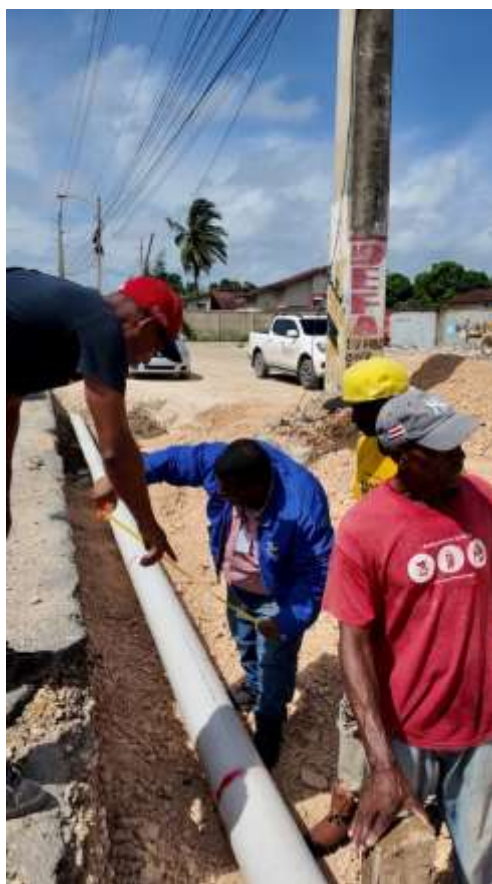
Colocación de Redes de Distribución de Agua Potable
