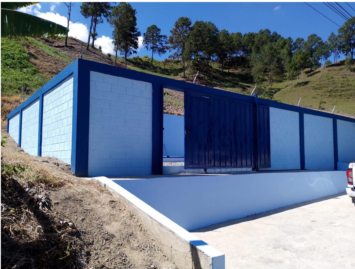
Evidencia 2. Tanque del Río Constanza — vista exterior/obra civil y cerramiento perimetral (Constanza).
