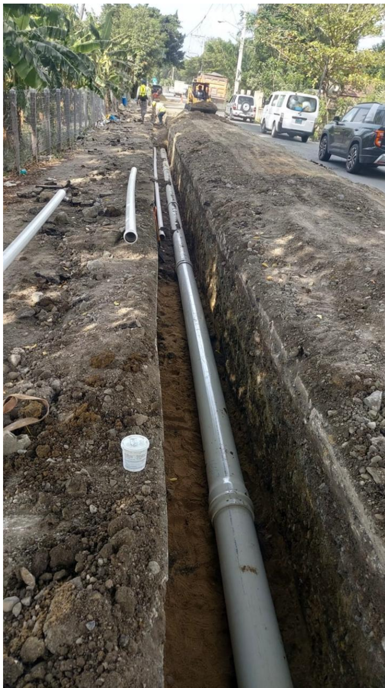
Evidencia 10. Barranca — instalación de tuberías y excavación para red de conducción (trabajos en ejecución).
