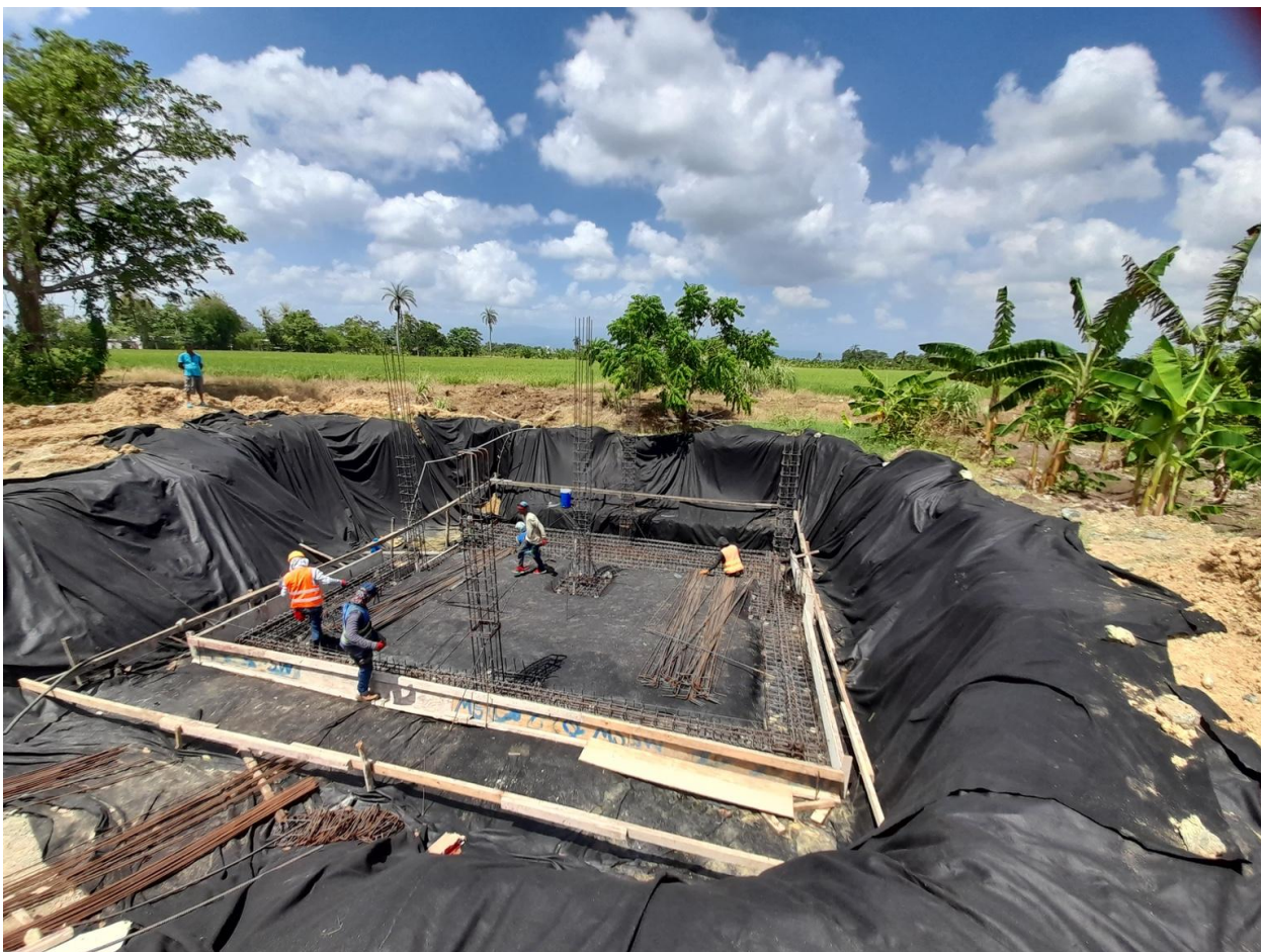
Evidencia 6. Sabana del Rey — avance de obra civil (excavación/armado y preparación de base).
