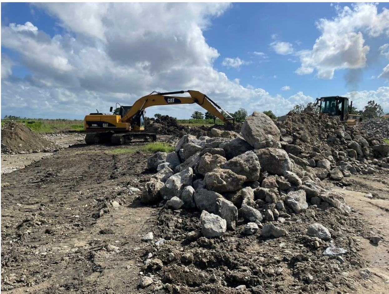
Evidencia 12. Movimiento de materiales y equipos pesados en frente de obra — Las Cabuyas (La Vega).
