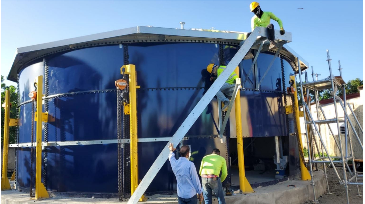
Evidencia 9. Barranca — montaje/instalación de tanque metálico (trabajos en ejecución).
