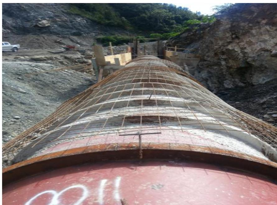
*Instalación Tubería Auxiliar de desvío Presa Guaiguí, en la provincia La Vega.*
