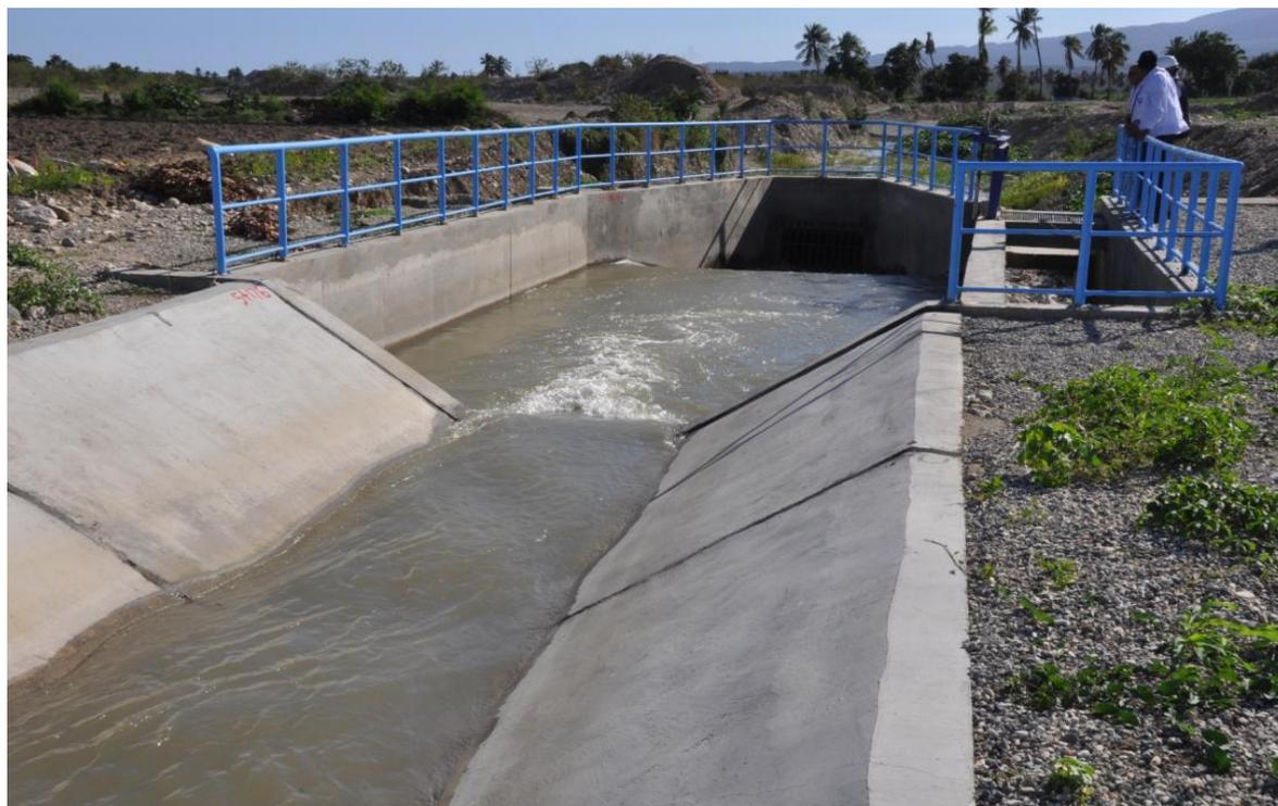
*El sifón del canal Ysura, en Azua, construido para mejorar la eficiencia de riego de este sistema que irriga la mayor parte de las tierras bajo producción del Valle de Azua.*
