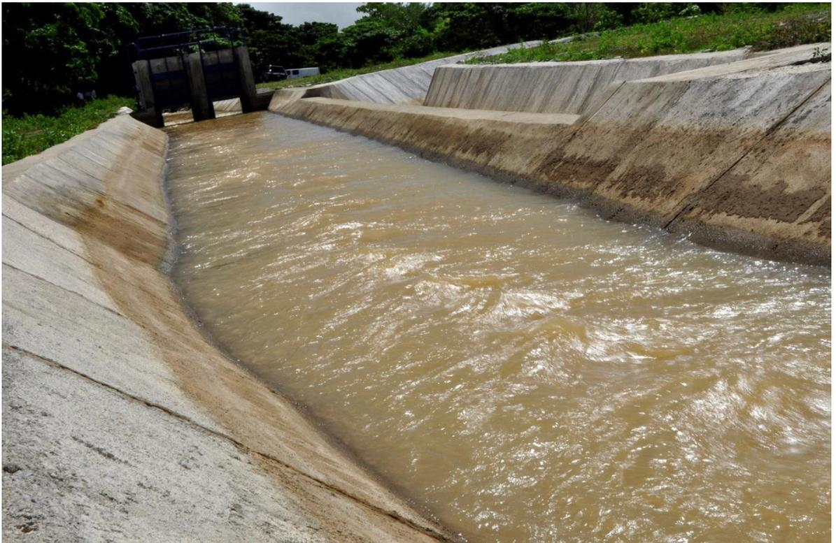
**En Bonao:** Rehabilitación y construcción de obras del canal Yuna- Cañabón, que incluye la construcción de 2.3 kilómetros de canal de llamada en tierra fuera de los bancos del río, aliviadero lateral en la toma directa, construcción de 5 puentes alcantarilla en los flumen 2,3 y 4 y puente alcantarilla en los sifones 1 y 2.
