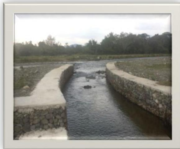
**En Bonao:** Rehabilitación y construcción de obras del canal Yuna- Cañabón, que incluye la construcción de 2.3 kilómetros de canal de llamada en tierra fuera de los bancos del río, aliviadero lateral en la toma directa, construcción de 5 puentes alcantarilla en los flumes 2,3 y 4 y puente alcantarilla en los sifones 1 y 2.
