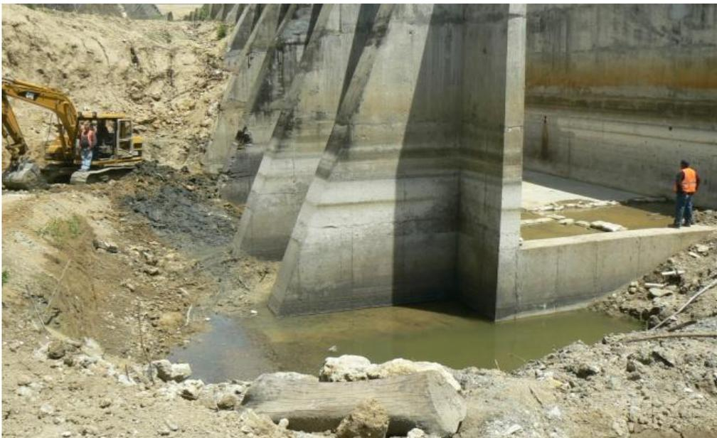
Excavación en el trasdós de los contrafuertes de los muros del cuenco de disipación. Presa de Chacuey.
