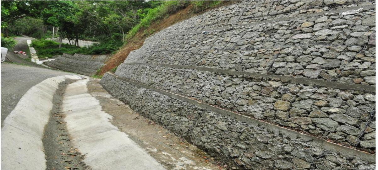
Uno de los muros de gaviones construidos por el INDRHI en la presa de Jigüey, para darle seguridad a la estructura de este complejo. También fueron construidas otras obras conexas con el objetivo de dar más seguridad a esa estructura.
