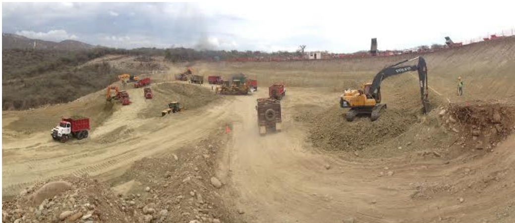
Movimiento de tierra caminos de acceso Presa Monte Grande
