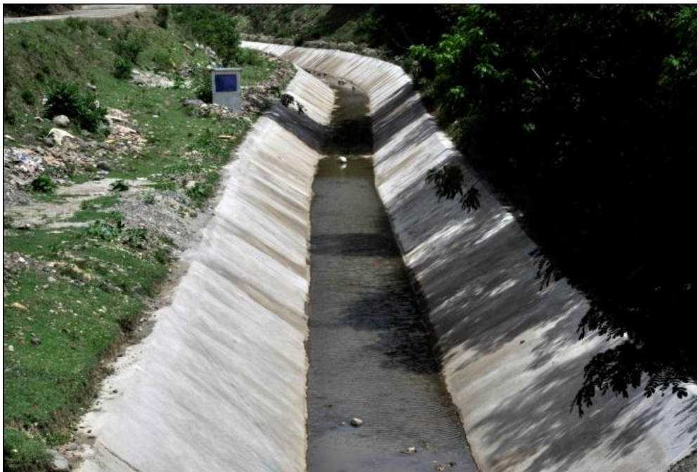
Rehabilitación Canal José Joaquín Puello, San Juan de la Maguana.
