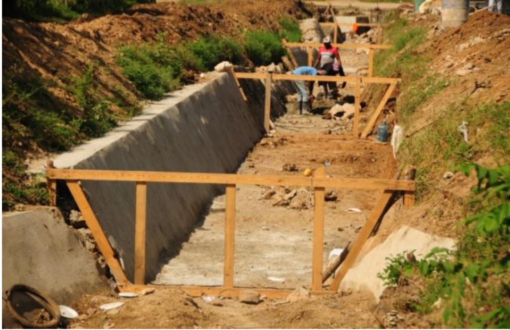
Rehabilitación Canal Juan Calvo, Provincia Dajabón
