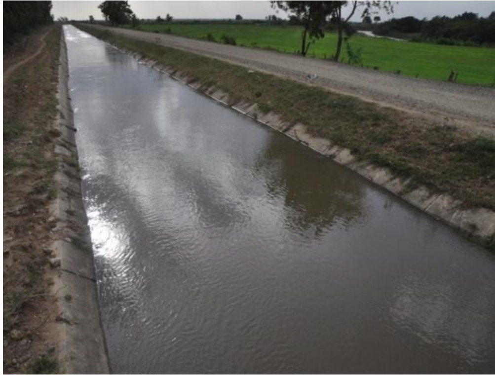
Vista de la rehabilitación del canal Fernando Valerio
