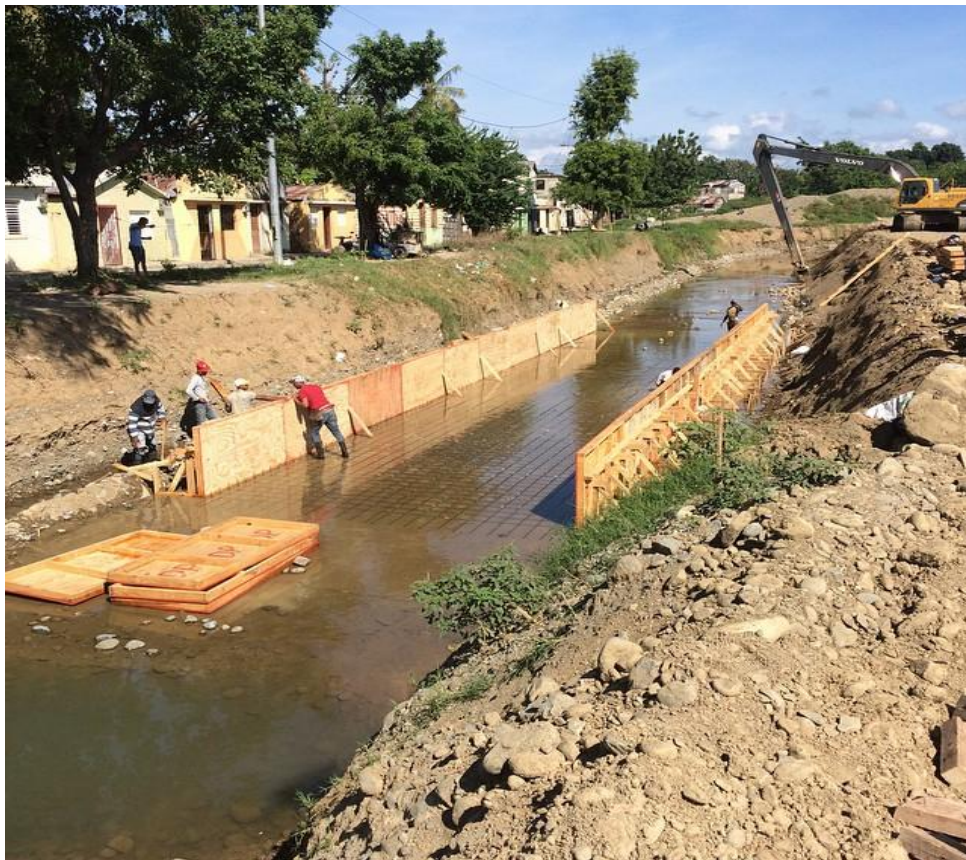
Canalización y encauzamiento arroyo Riito
