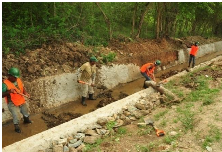
Obreros laborando en la rehabilitación del canal La Vigía, Dajabon
