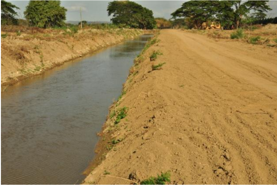
Vista trabajos de Drenaje Finca No.6, Valle de Azua
