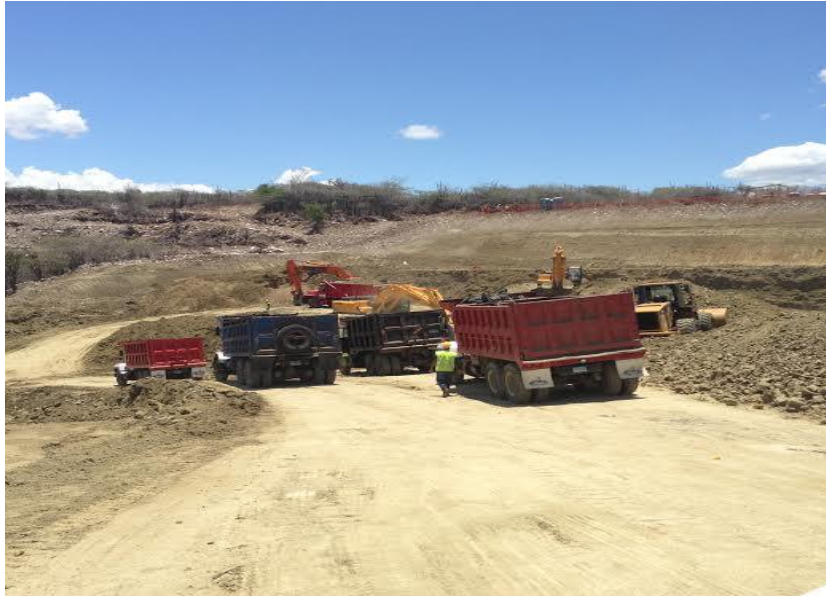
Movimiento de tierra caminos de acceso Presa Monte Grande
