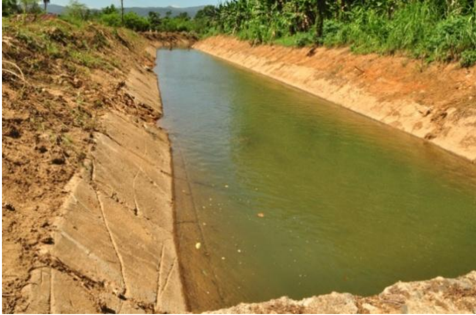
Rehabilitación Canal Boba
