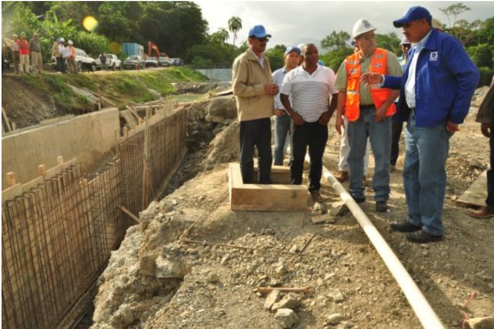
Reconstrucción Berma Canal Mijo E-2+800 y diferentes Tramos Laterales
