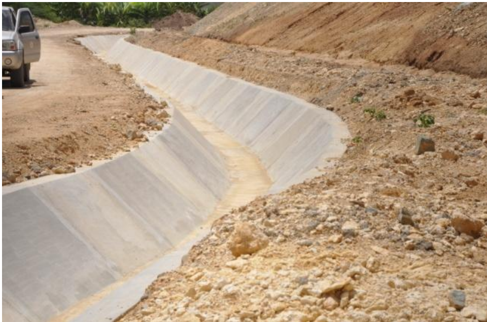
Vista Canal Maguaca rehabilitado
