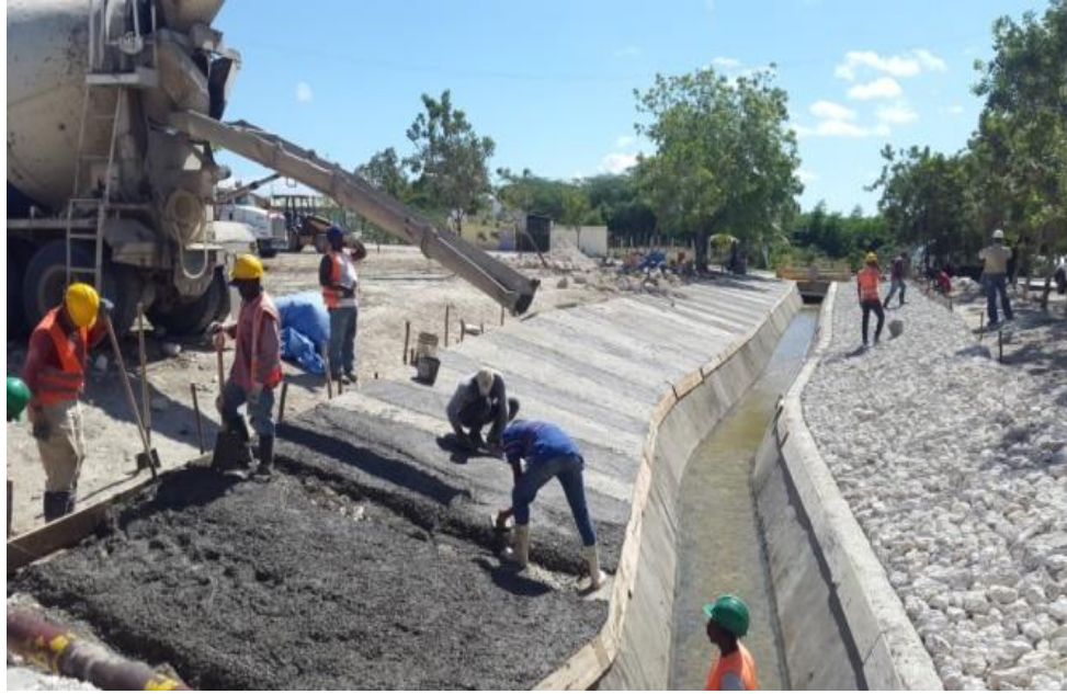
Rehabilitación Canal Cristóbal
