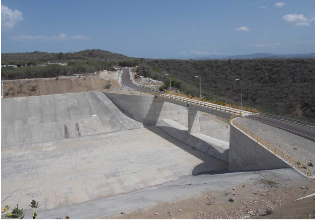
Vertedero de servicio Presa Sabana Yegua
