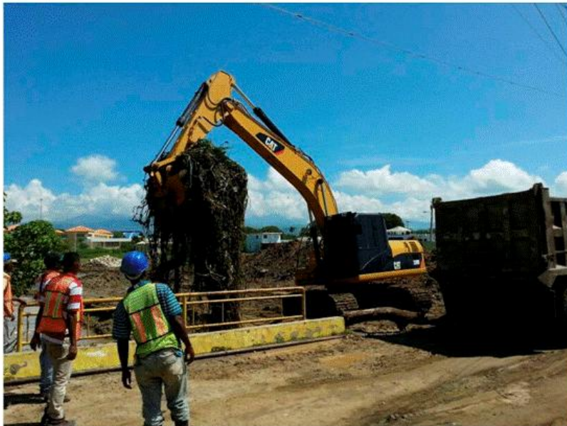
Saneamiento de cañada tengerengue, remoción de malezas y material orgánico del fondo del cauce.
