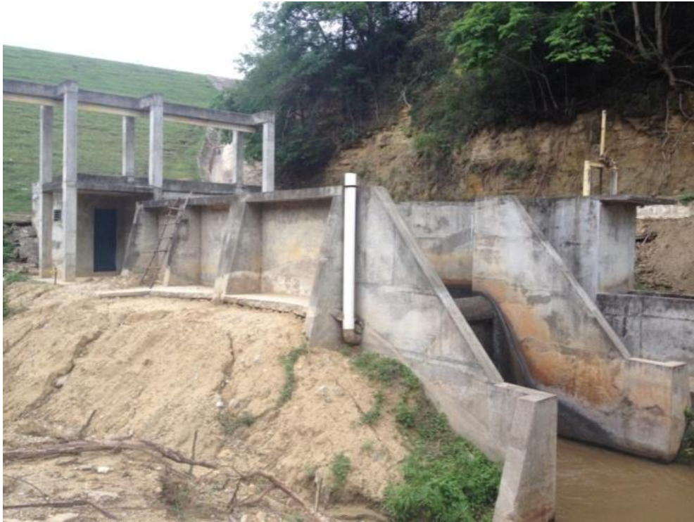
Muro intervenido Presa de Chacuey
