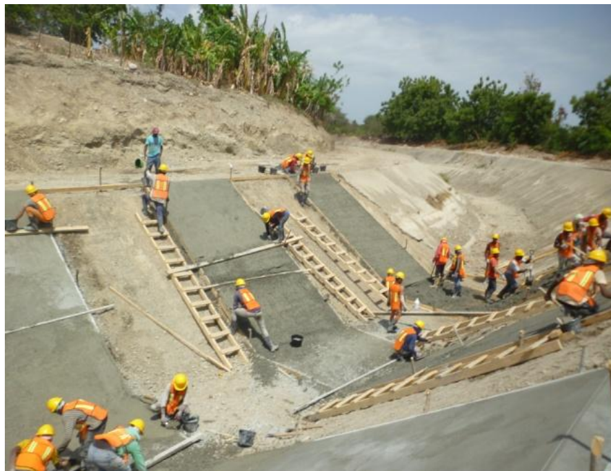
Revestimiento prolongación Canal
