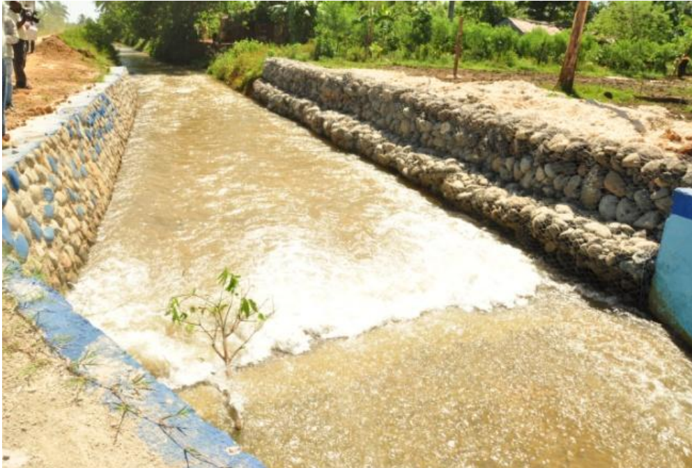
Rehabilitación Canal Boba
