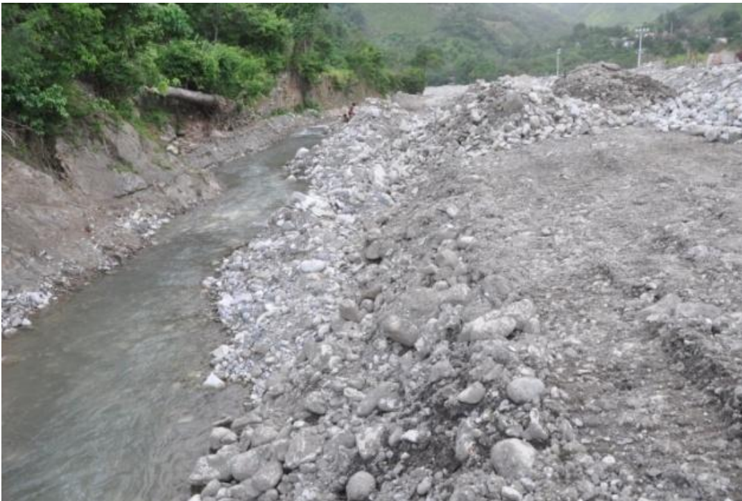
Vista de los trabajos de Adecuación Tramo Río Jura Márgenes por Inundación en la Comunidad de Peralta, Azua
