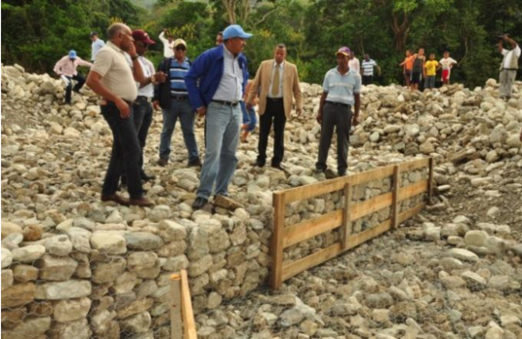
Director Ejecutivo y Tecnicos supervisando trabajos Adecuación Tramo Río Jura Márgenes por Inundación en la Comunidad de Peralta, Azua.
