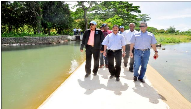
Rehabilitación del Dique y Canal Magua-Canita, en Sabana de La Mar
