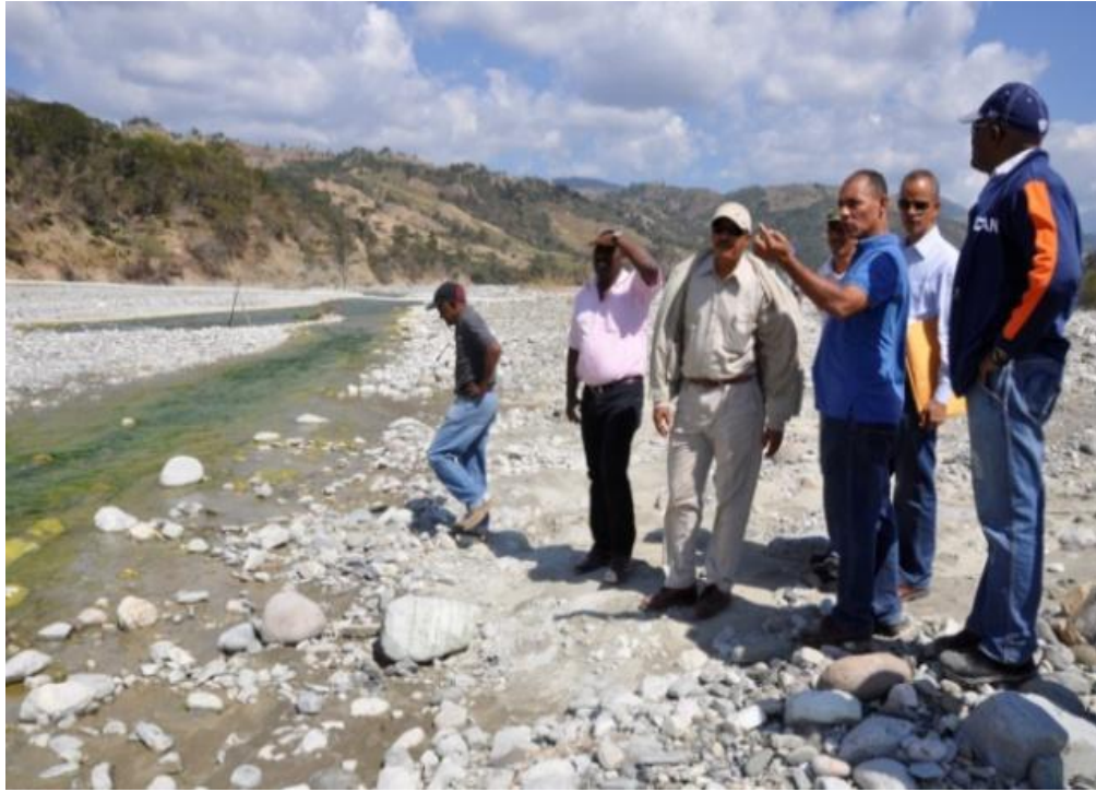
Director Ejecutivo y técnicos supervisando trabajos Rehabilitación Obra de Toma Río Las Cuevas, Padre Las Casas, Azua.
