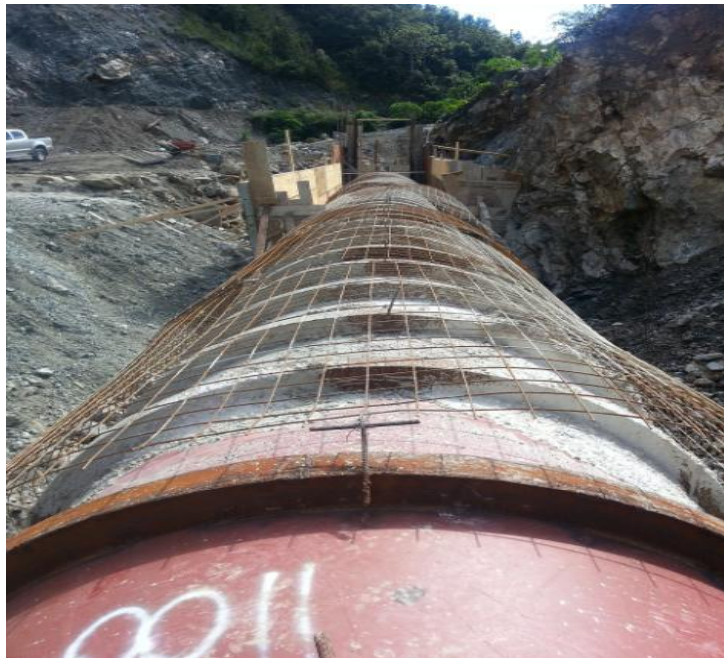
Instalación Tubería Auxiliar de Desvío
