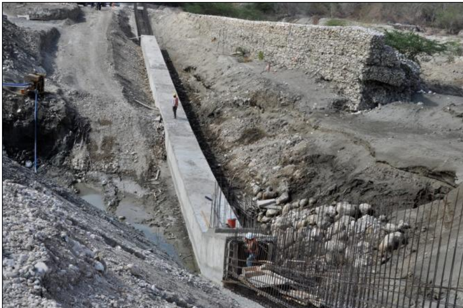
Construcción Sifón El Salado, Neyba
