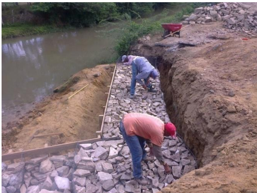
Rehabilitación del Canal La Antona
