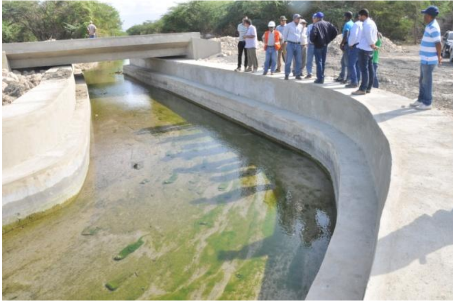
Construcción Canal Neyba
