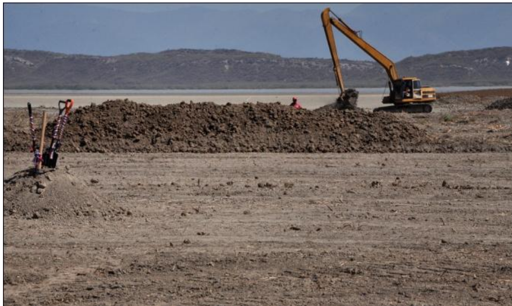
Trabajos de adecuación y conformación de Laguna de Cabral
