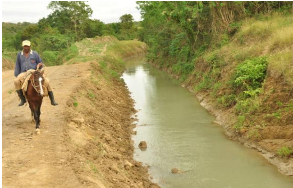
Rehabilitación de los Canales Matayaya, Macasías N° 1 y Caña Matayaya
