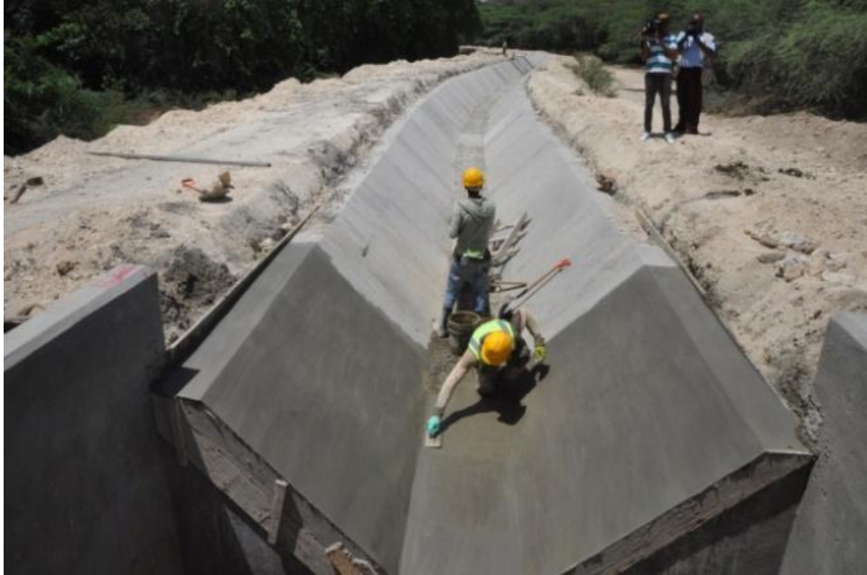
Trabajos de terminación Rehabilitación del Canal Maguaca
