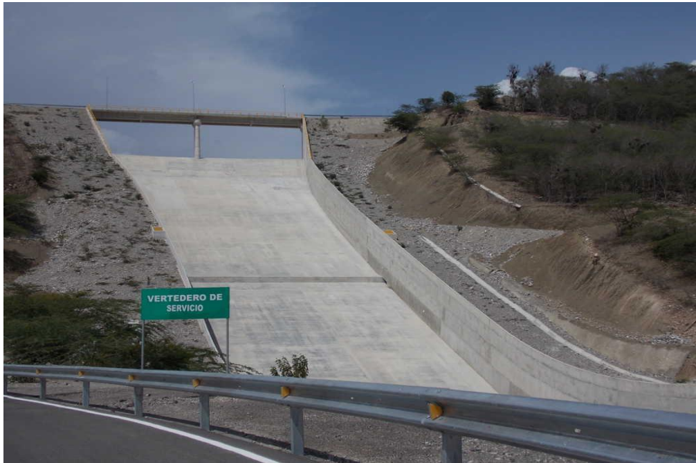
Vertedero de servicio Presa Sabana Yegua
