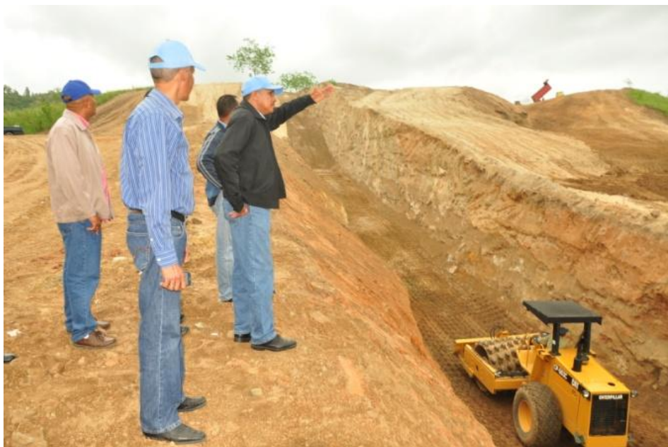
Construcción Presa La Piña
