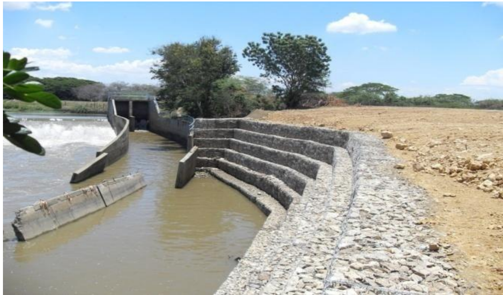
Construcción muro de gavión en la obra de toma canal Fernando Valerio.
