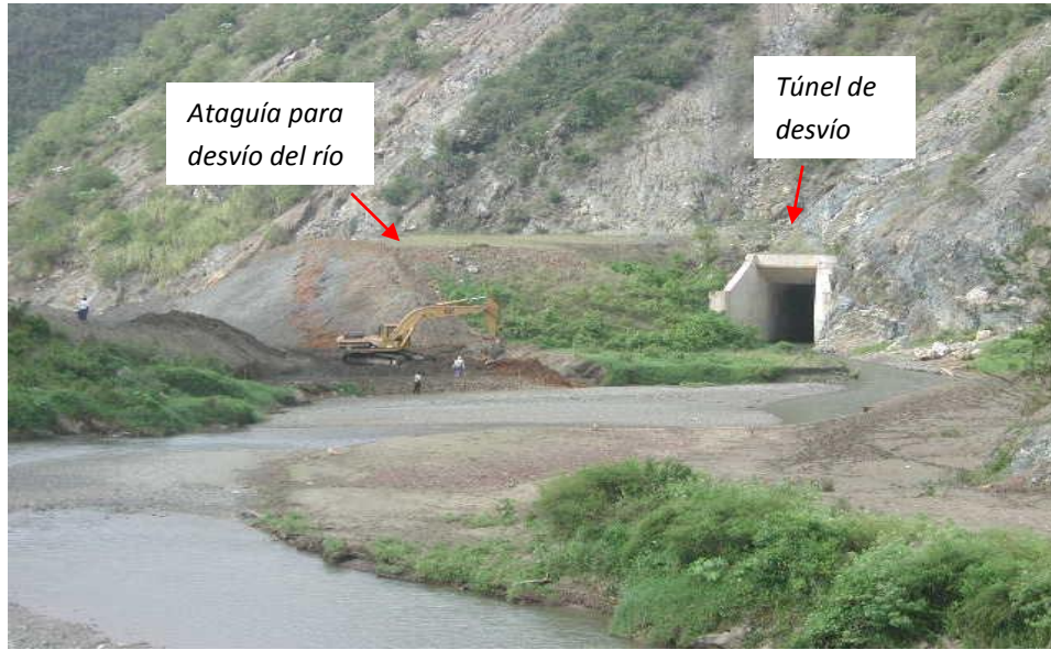
Trabajos en la Primera Etapa del Proyecto
