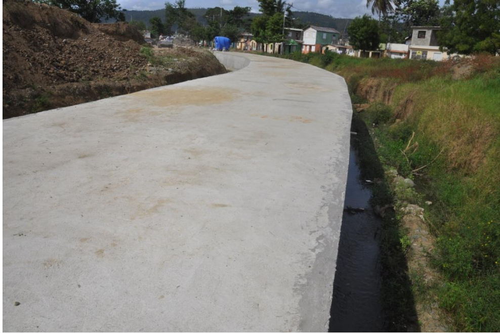
Canal cerrado en canaleta tramo arroyo Riito
