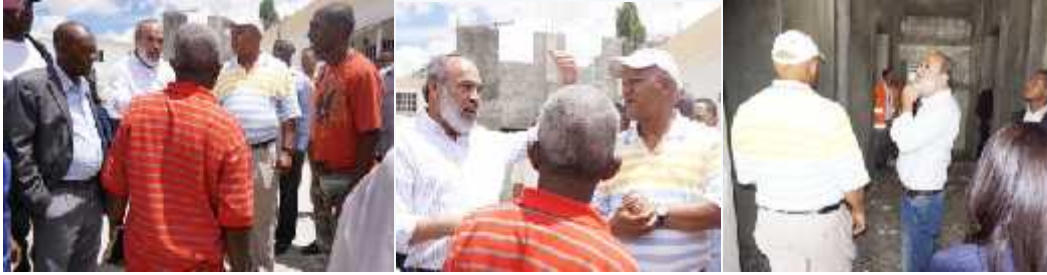
SEGUIMIENTO A LOS TRABAJOS DE TERMINACIÓN DEL SUB CENTRO DE SALUD HONDO VALLE
