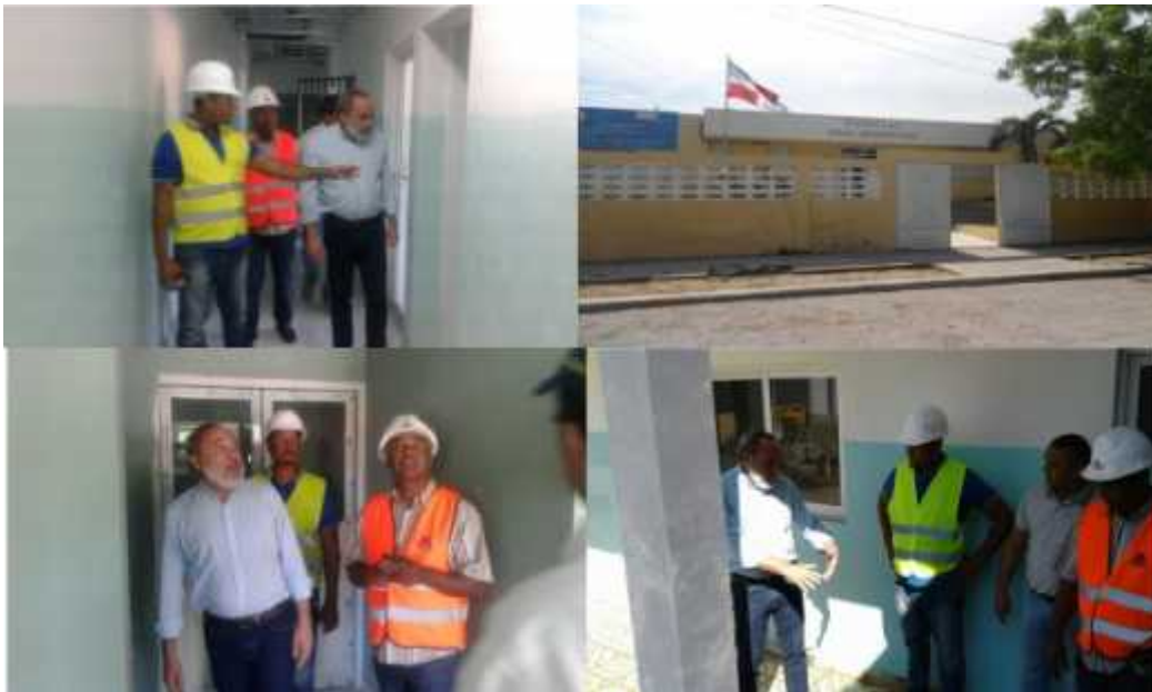
REMOZAMIENTO Y EQUIPAMIENTO HOSPITAL DE JIMANÍ
