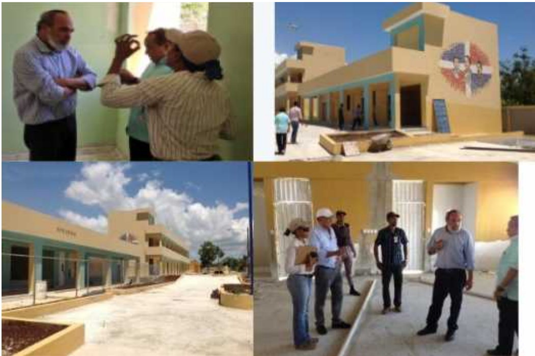
INSPECCIÓN ESCUELA BÁSICA DE LOS CONUCOS, DE GUAYACANES
