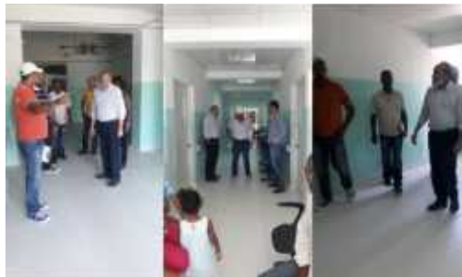
HOSPITAL MUNICIPAL DE JIMANÍ LA OFICINA DE INGENIEROS SUPERVISORES COORDINA LA TERMINACIÓN DEL PROYECTO
