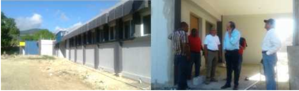
SUPERVISIÓN HOSPITAL DE LA DESCUBIERTA
