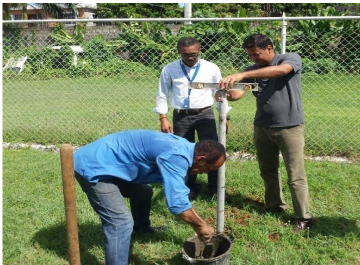
Imagen Instalación de Pluviómetro Colector.
