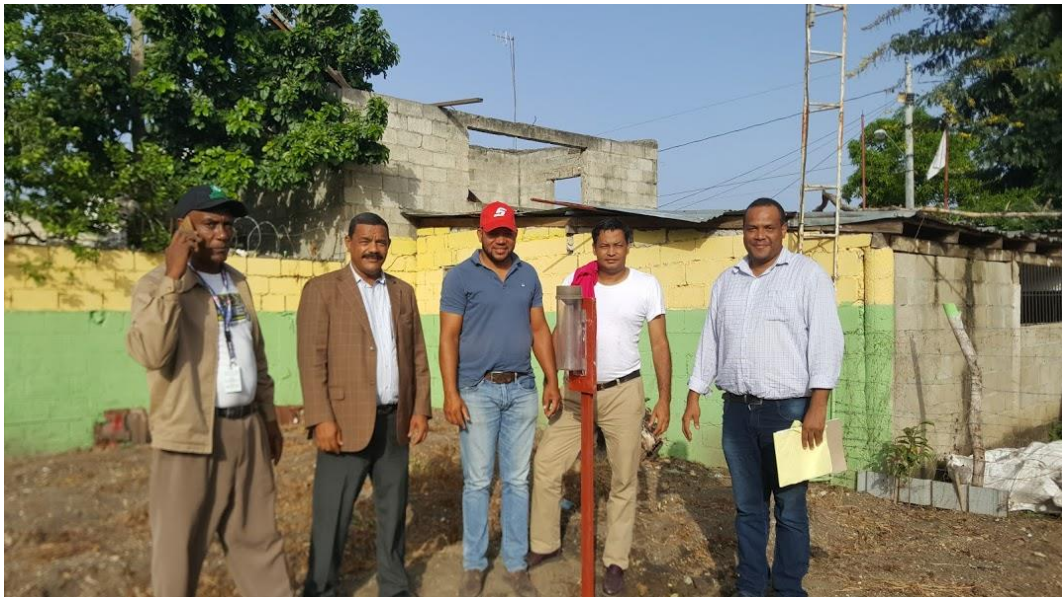
Foto: Recuperación de Estación Meteorológica de Tamboril , instalación de equipos con el personal técnico de ONAMET.
